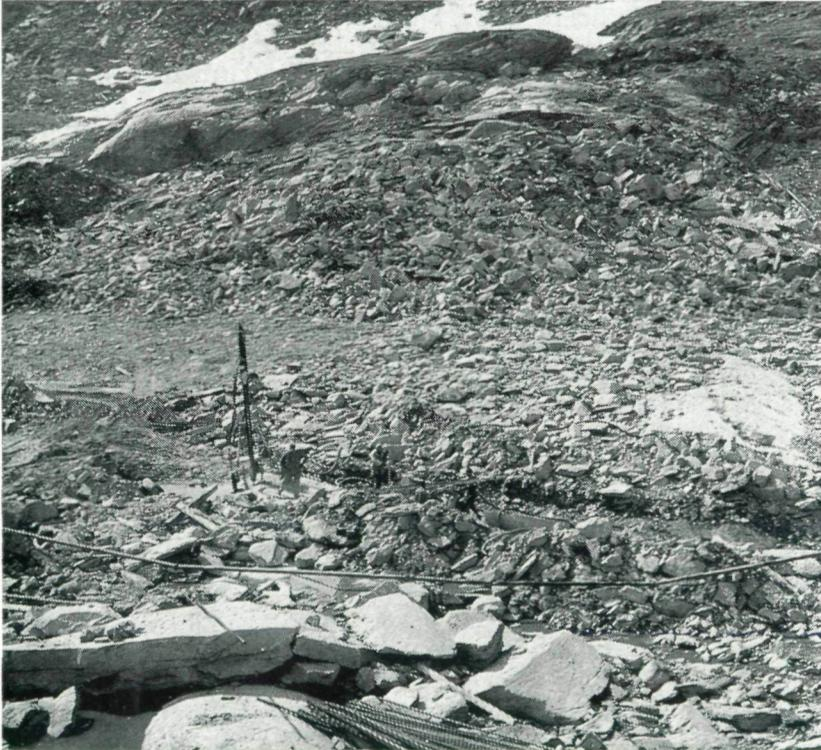
Abb. 2: Rotationsbohrung in der tiefsten Einkerbung der Großsee-Schwelle.
