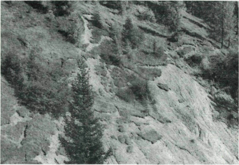
Abb. 17: Detailausschnitt des völlig in ein Schollenmosaik aufgelösten Mittelstückes des Sackungsbereiches mit tiefgreifenden Muschelanbrüchen
