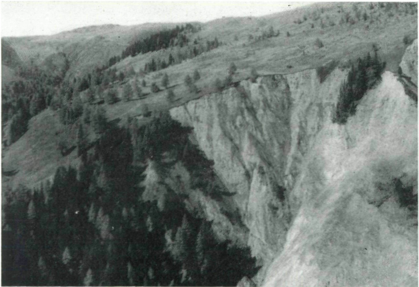
Abb. 18: Flugbildaufnahme des obersten Einzugsgebietes des Eggenanbruches. Der insgesamt 20 ha messende und 400 Höhenmeter aufweisende Anbruch in grobblockigen Zweiglimmer-Quarz-Schiefern und Gneisen im Wechsel mit hochteildbeweglichen Graphit-Schiefern dürfte der größte Geschiebelieferant für das gesamte Kärntner Lesachtal sein
