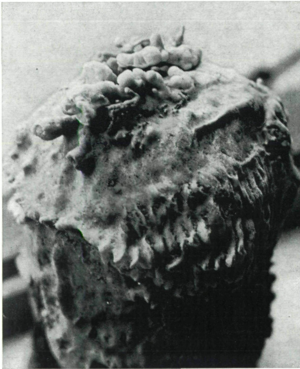
Abb. 2: Formenreiche Sinterentwicklung auf Pfosten der Stollenverschalung. (Foto: M. Leischner)
