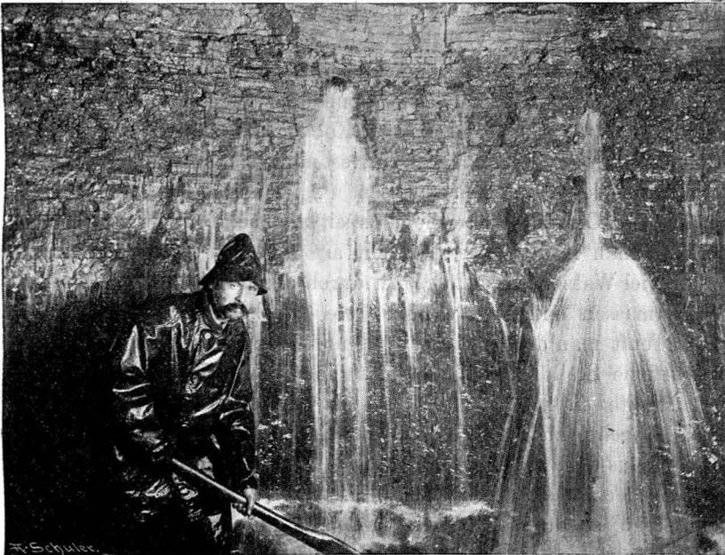
Entwässerungsabzug eines sehr grossen, weit ausgedehnten, schwammartig porösen Gebietes jener Dolomite. Auf solche Weise konzentrieren sich hier breite, grosse Wassermassen in Röhren und fliessen so auf engstem Raume ab, gleich einer natürlichen Drainage<sup>1</sup>. Dazu kommt, dass die Wassermassen jenes oberen, in der Photographie dargestellten Wasserhorizontes leicht möglicherweise durch vertikale Kanäle oder Spalten mit den Massen des zweiten, tieferen Horizontes
