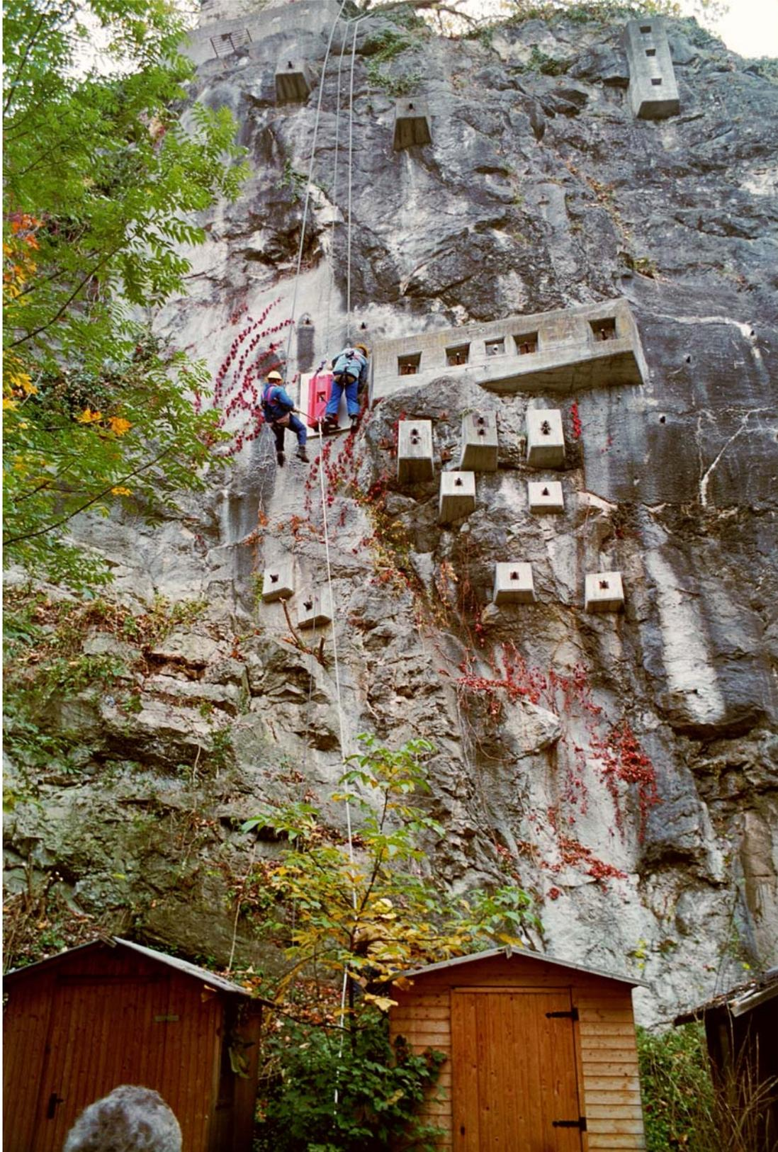
Abb. 3: Untersuchungsbereich Nonnberg – mit Felsankern gesicherter Bereich
