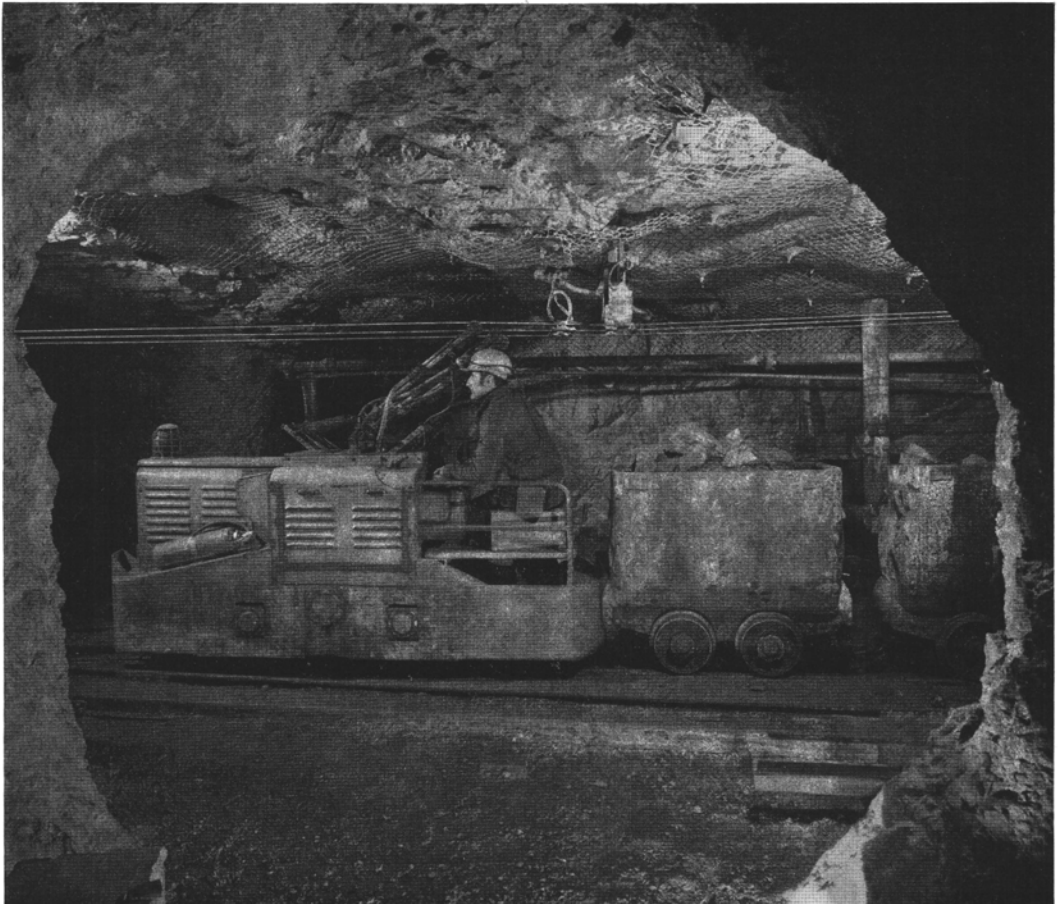
Abb. 15. Förderung mit Fahrdrathlok, Firstsicherung durch Gebirgsanker mit Drahtnetz
