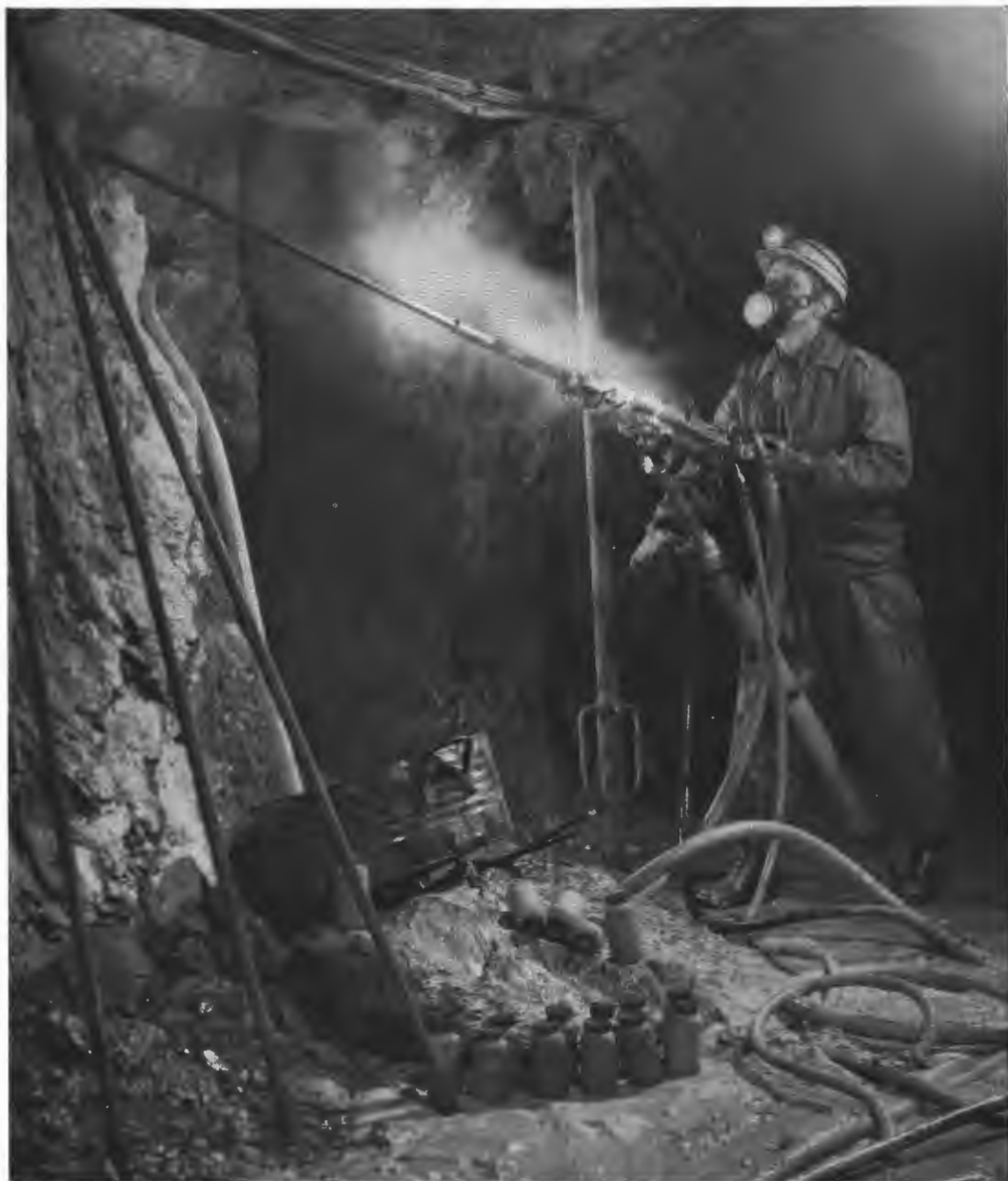
Abb. 8. Proben-Entnahme, Bohrungen ersetzen die teuren Aufklärungsstrecken
