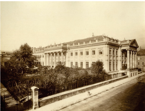
Abb. 3: Historische Ansicht des Palais Rasumovsky (Archiv GBA).
