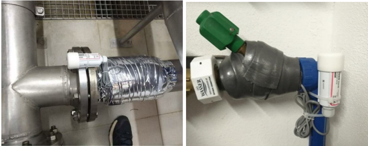
Abbildung 4: Einbau der Temperatursensoren auf metallischen Oberflächen (links) und auf Absperrventilen (rechts)
