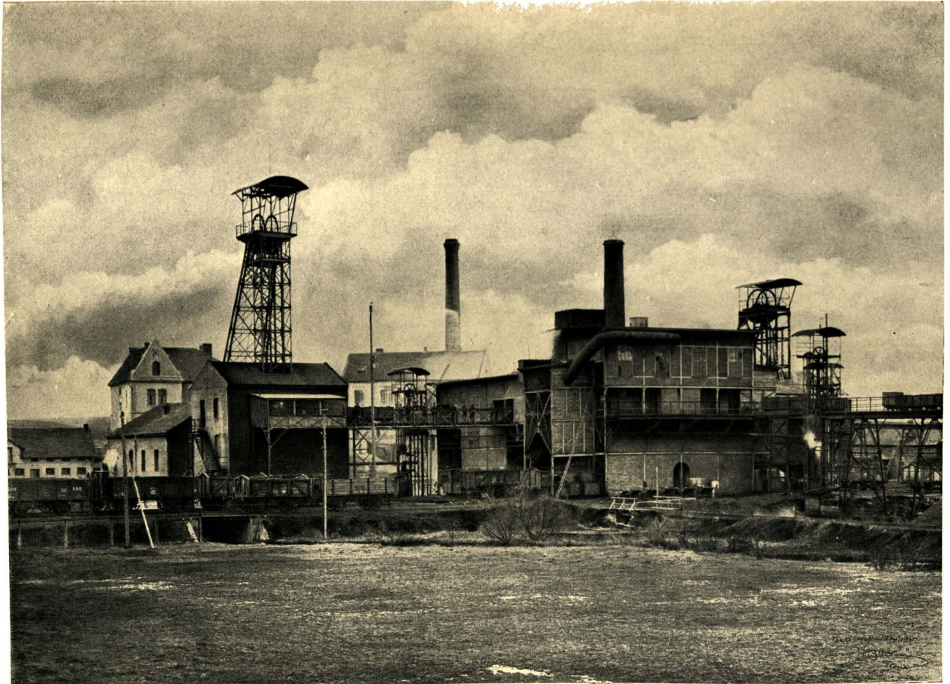
Doblhoff III-Schächte in Modlan bei Mariaschein (Brüxer Kohlen-Bergbau-Gesellschaft).
