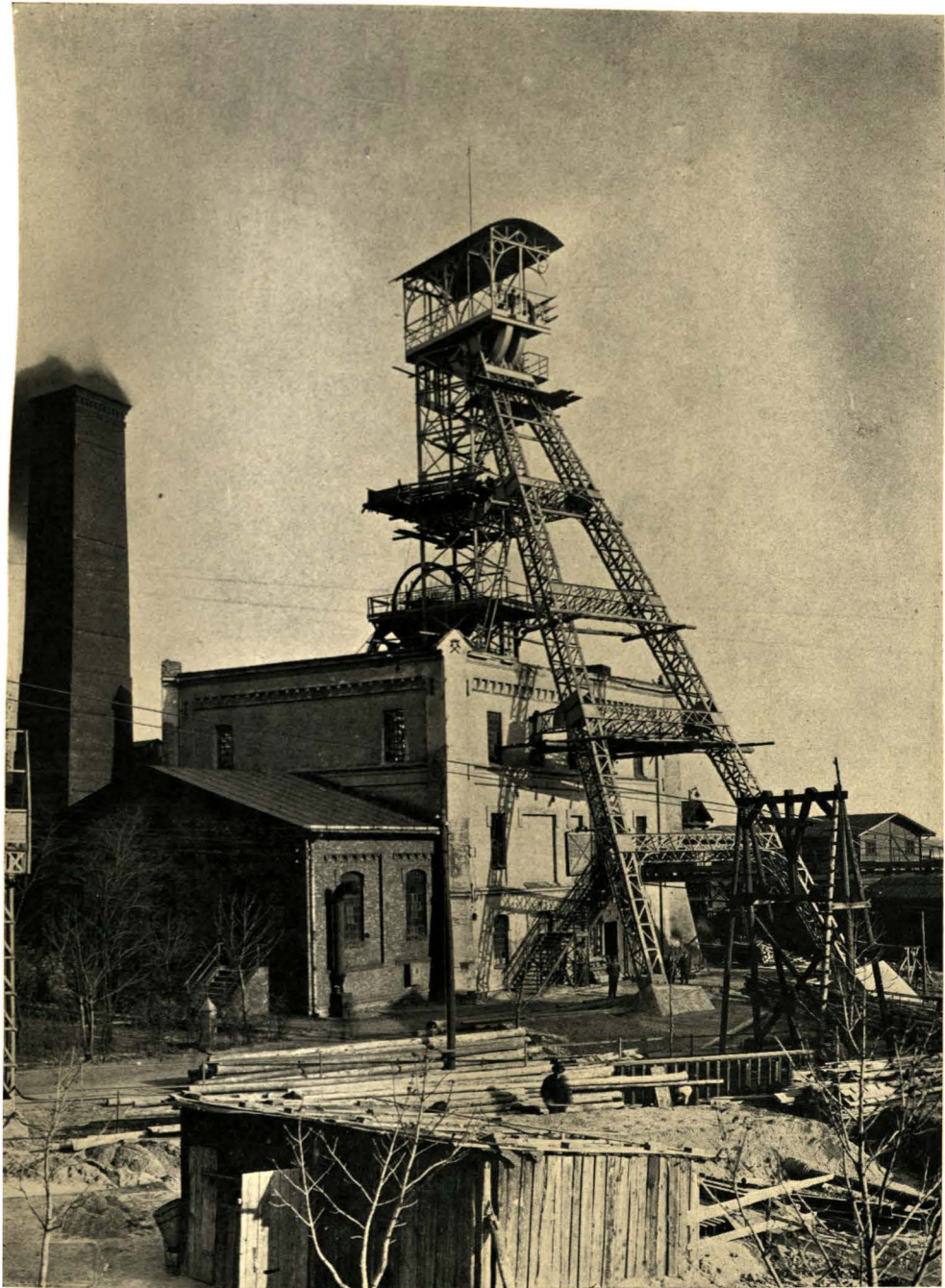
Franziska-Schacht, im Umbau begriffen (H. Graf Larisch-Mönnich).
