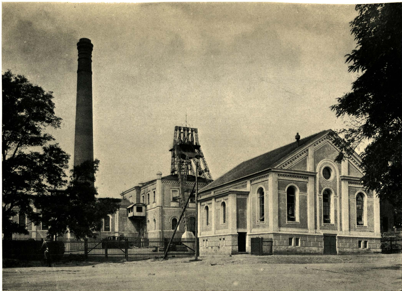
Simson-Schacht in Zbeschau, Mähren (Rossitzer Bergbau-Gesellschaft).
