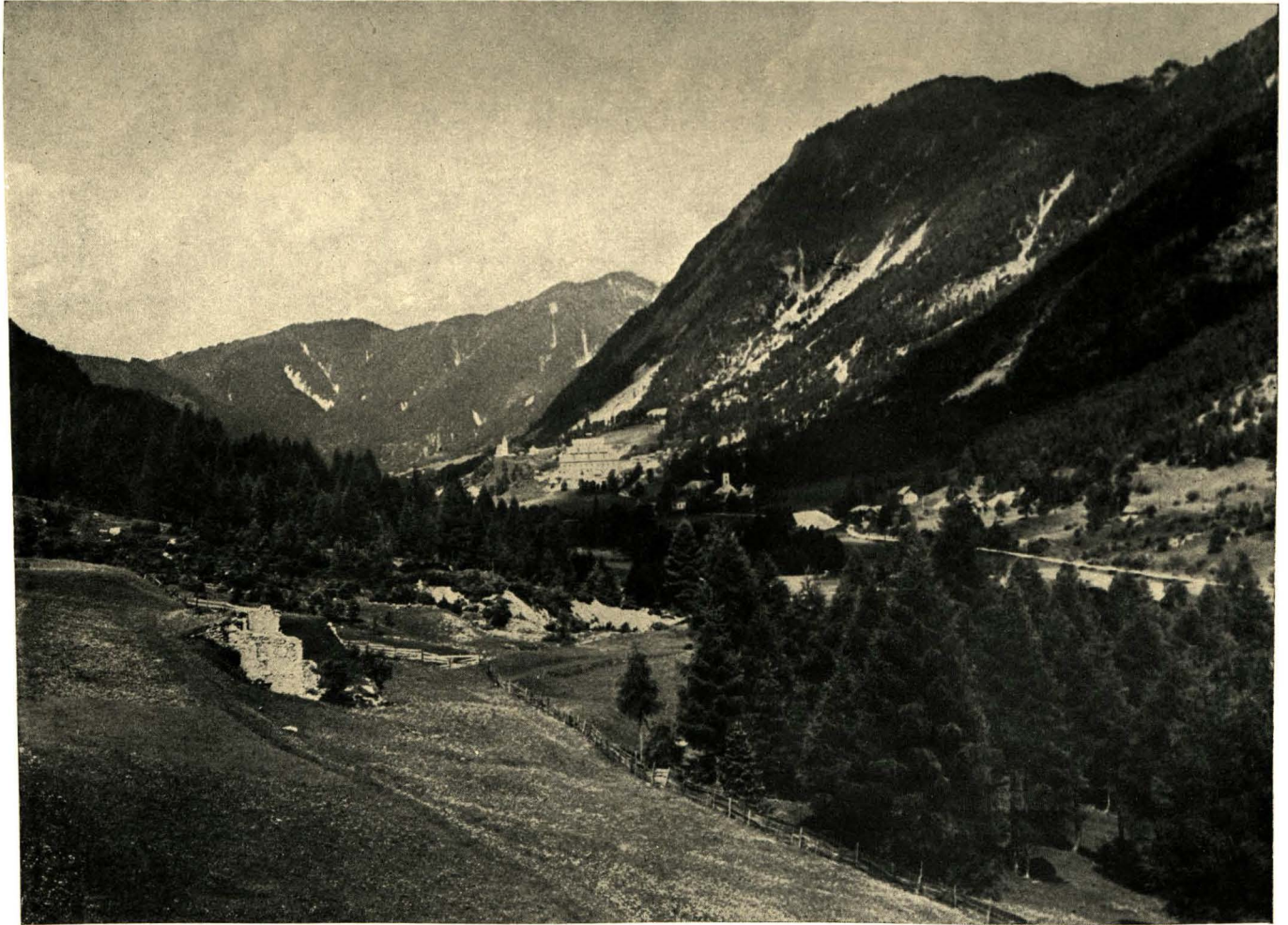
Antoni-Schacht in Kreuth bei Bleiberg mit der neuen Aufbereitung, rechts der Erzberg.
