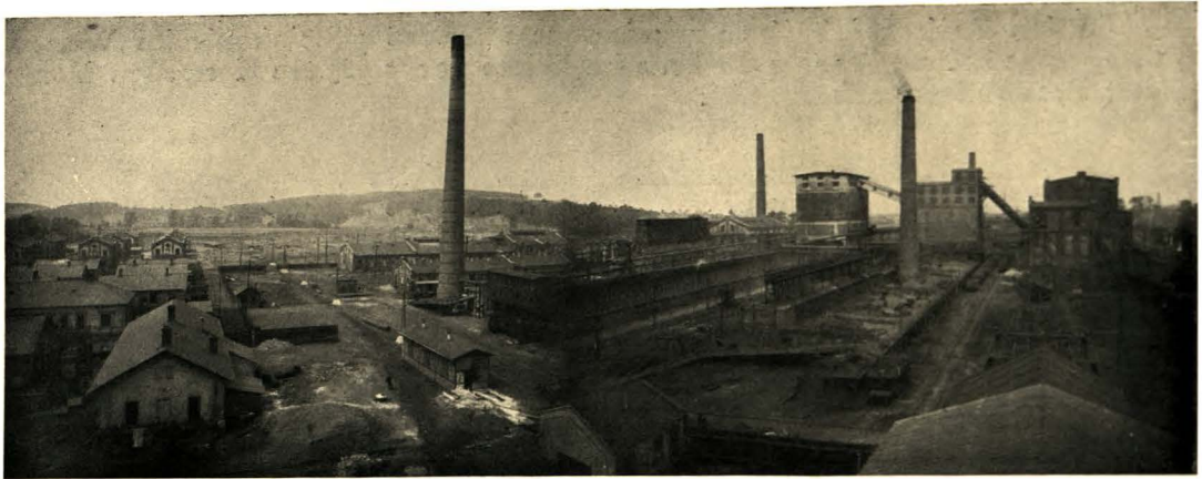
Koksanstalt am Franz-Schachte in Oderfurt (Kaiser Ferdinands-Nordbahn).
