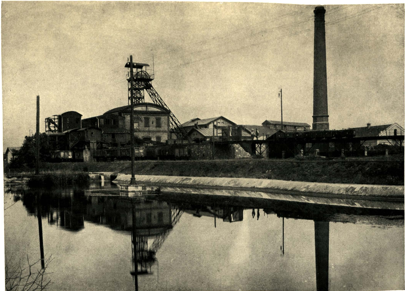
K. k. Schacht Julius III in Kopitz bei Brügge.
