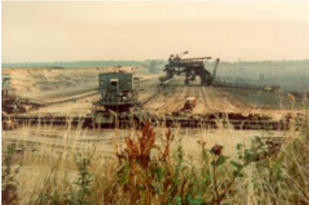
Abb. 5-2-38: Bagger 1264 E 1120 im 2. Abraumschnitt Tagebau Cospuden
