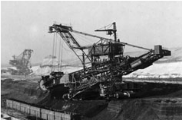
Abb. 4-9-4: Bagger 128 im Großtagebau Schleenhain (Foto: Archiv BRÄUTIGAM)
