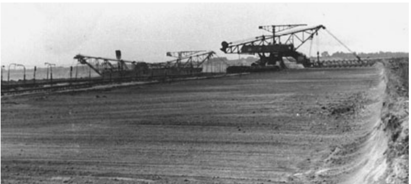
Abb. 5-2-19: Bagger 598 Es800, Einsatz von 1938 bis 1962 im Mittelabraum, danach bis 1994 im Vorschnitt des Tagebaus Böhlen/Zwenkau (1993) (Foto: SCHUBERT)
