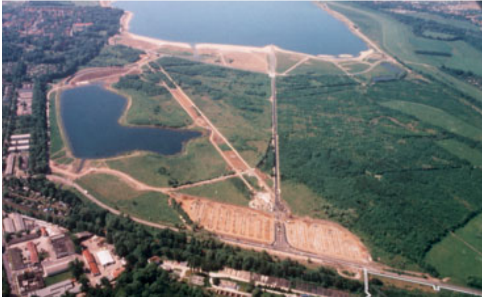
Abb. 6-2-2-1: Nordufer Cospudener See (Luftaufnahme) (Foto: BERKNER)
