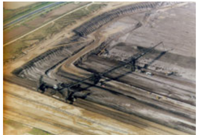
Abb. 5-2-18: Abraumförderbrücke AFB 18 im Tagebau Zwenkau (1998) (Foto: LMBV mbH)
