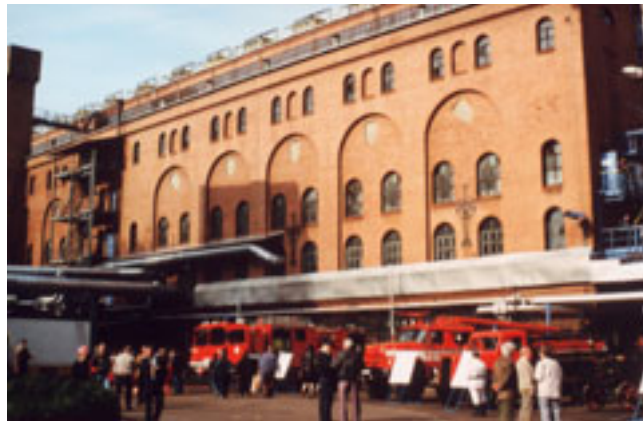
Abb. 6-1-2: Brikettfabrik Phoenix zum 90. Betriebsjubiläum 1996 (Foto: BERKNER)
