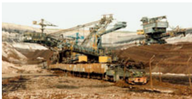
Abb. 6-2-8-1: Bagger 1410 SRs 1200 bei der Zugbelastung (1995) (Foto: Archiv MIBRAG mbH)
