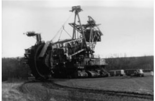
Abb. 5-2-45: Transport des Neubaugeräts 1552 SRs 2000 zum Einsatzort
