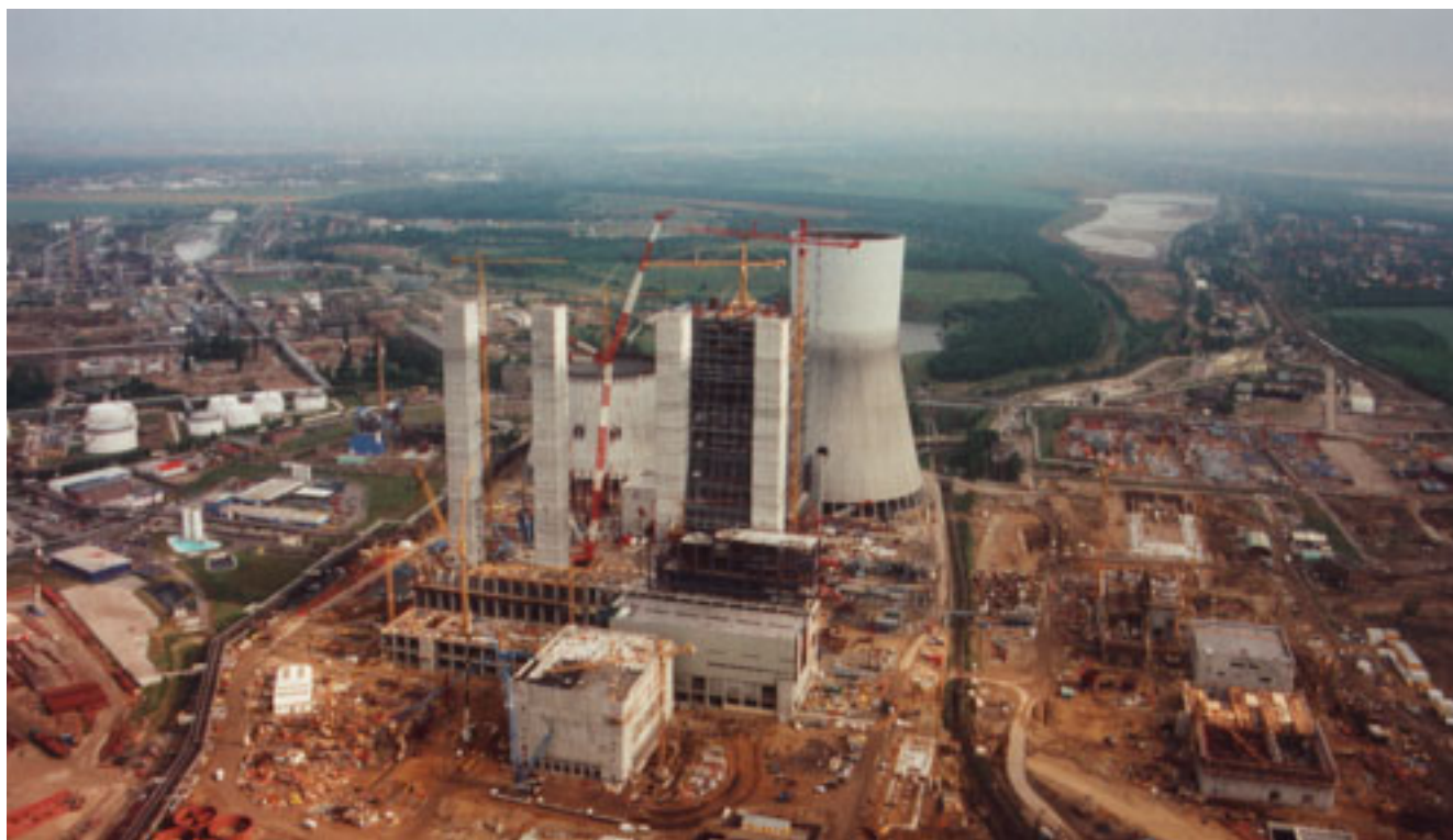
Abb. 5-4-12: Neubaukraftwerk Lippendorf im Bau (Foto: BERKNER)
