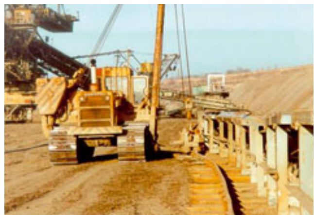
Abb. 5-2-50: Rückarbeiten an der Bandanlage Espenhain
