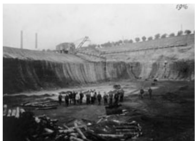
Abb. 5-2-4: Kohlefreilegung durch Abraumbagger mit ungeführter Eimerkette im Tagebau Borna-Nord (1916). Zu erkennen ist auch der Einsatz von Kriegsgefangenen (Bewachung mit aufgepflanztem Bajonett) (Foto: Archiv KAPPLER)
