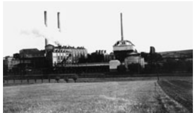
Abb. 4-8-2: Brikettfabrik Rositz mit Generatoranlage (Foto: Archiv BRÄUTIGAM)
