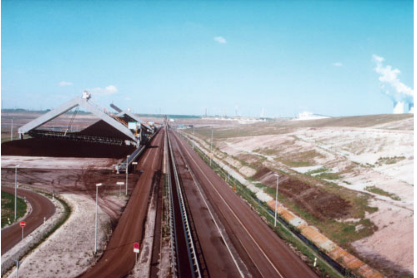
Abb. 1-5: Kohlemisch- und Stapelplatz Tagebau Vereinigtes Schleenhain
