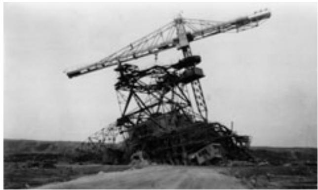
Abb. 7-8-4: Die Kippenrutschung im Tagebau Haselbach vom 17.08.1977 (Foto: Archiv Bergamt Borna)
