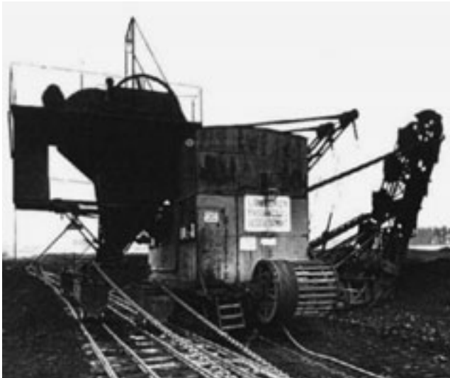
Abb. 5-2-3: LMG-Eimerkettenbagger mit Raupenfahrwerk in der Grube Kraft I im Einsatz (1920) (Foto: Archiv KAPPLER)
