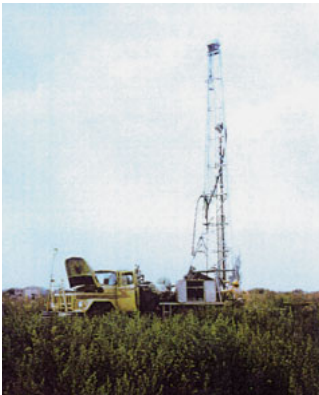
Abb. 2-2-2: Rotarybohrgerät bei Markkleeberg-Zöbiger im Tagebaubereich Cospuden
