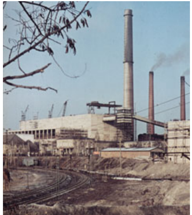
Abb. 5-4-2: Kraftwerk Borna in der Rekonstruktionsphase 1963...66
