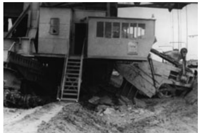
Abb. 2-3-9: Böschungsgrundbruch am Absetzer 1007 im Tagebau Bockwitz am 19.07.1986
