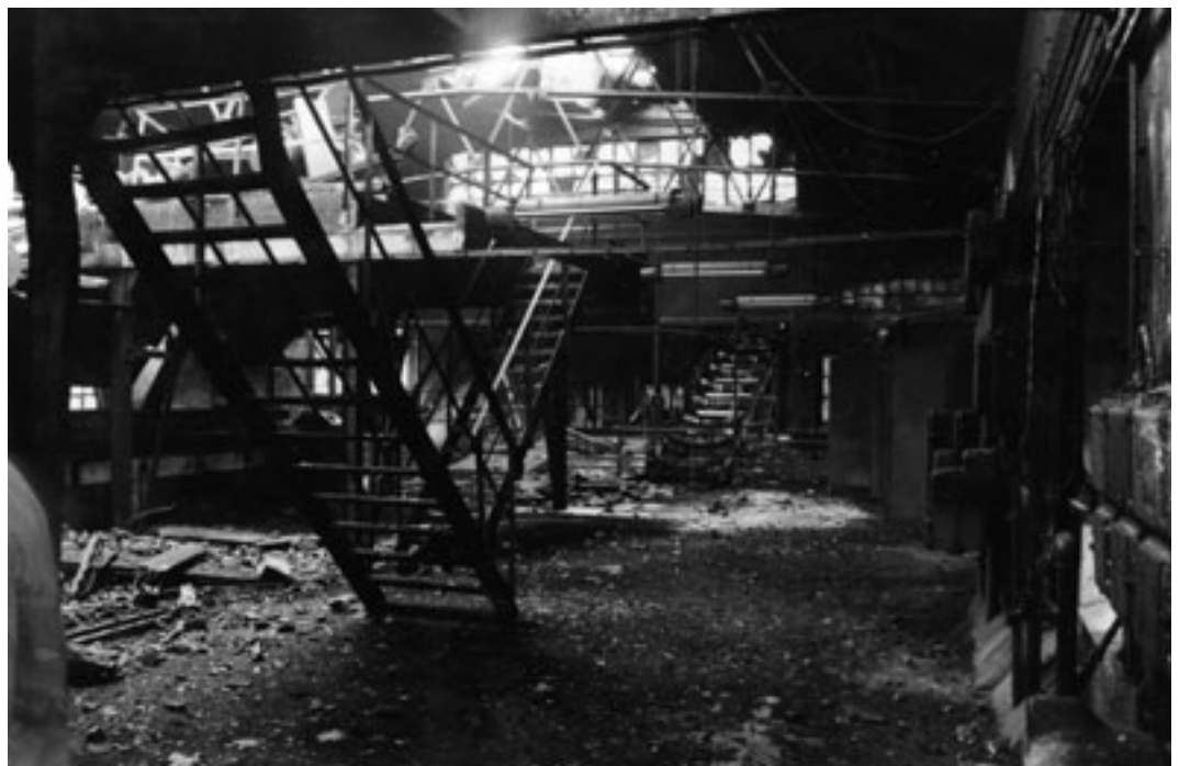
Abb. 7-8-6: Brikettfabrik Regis – Großbrand vom 21.12.1982 – Obere Etage Roh- kohleaufbereitung (Foto: Archiv Bergamt Borna)
