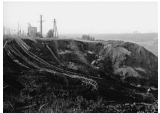
Abb. 2-3-5: Tagebau Zwenkau, Stellwerk 101, Rutschung vom 03.08.1978
