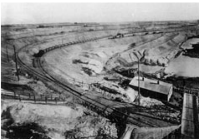
Abb. 5-2-6: Dampflokbetrieb und Holzkastenkipper, 11 Handkippen übereinander (1917) (Foto: Archiv KAPPLER)
