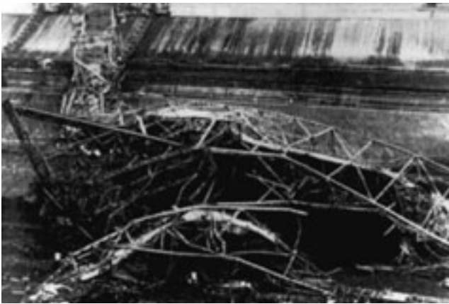
Abb. 7-8-1: Die am 12.05.1937 eingestürzte Abraumförderbrücke im Tagebau Böhlen
