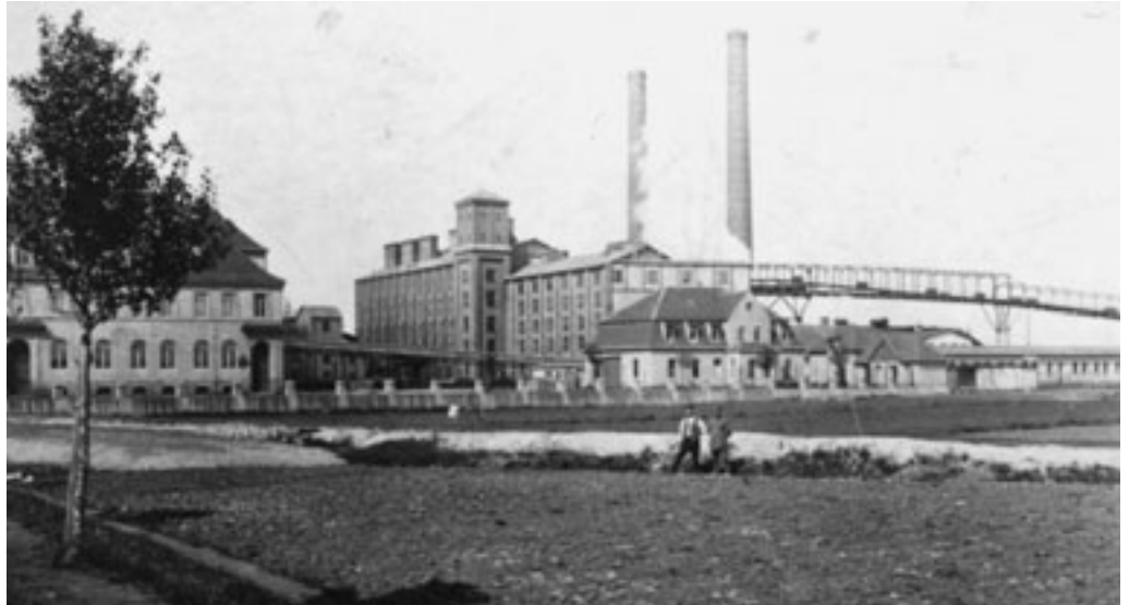
Abb. 5-3-1: Die Brikettfabrik Deutzen in den 20er Jahren (Foto: Archiv BRÄUTIGAM)
