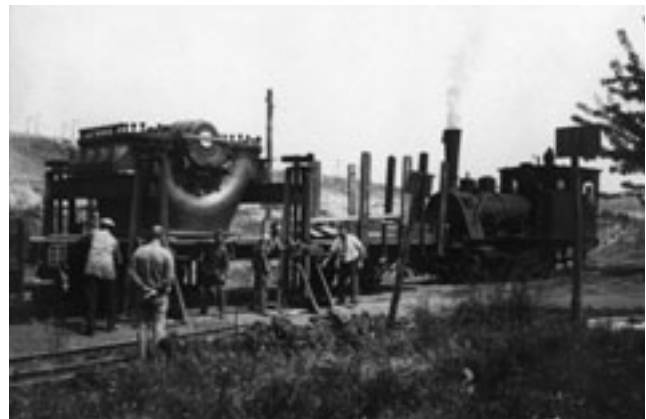
Abb. 5-4-5: Ausrüstungstransport beim Bau des Kraftwerkes Böhlen
