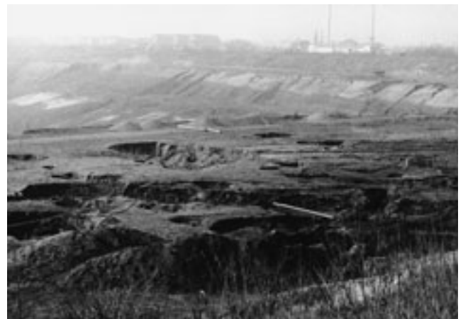
Abb. 2-3-12 Tagebau Espenhain, Sicherheitspfeiler Markkleeberg, Erdfallbildungen im Dezember 1986
