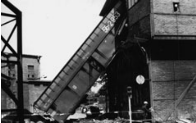
Abb. 7-8-12: Überfahren eines Gleisabschlusses in der Brückfabrik Lobstädt vom 10.07.1987 (Foto: Archiv Bergamt Borna)
