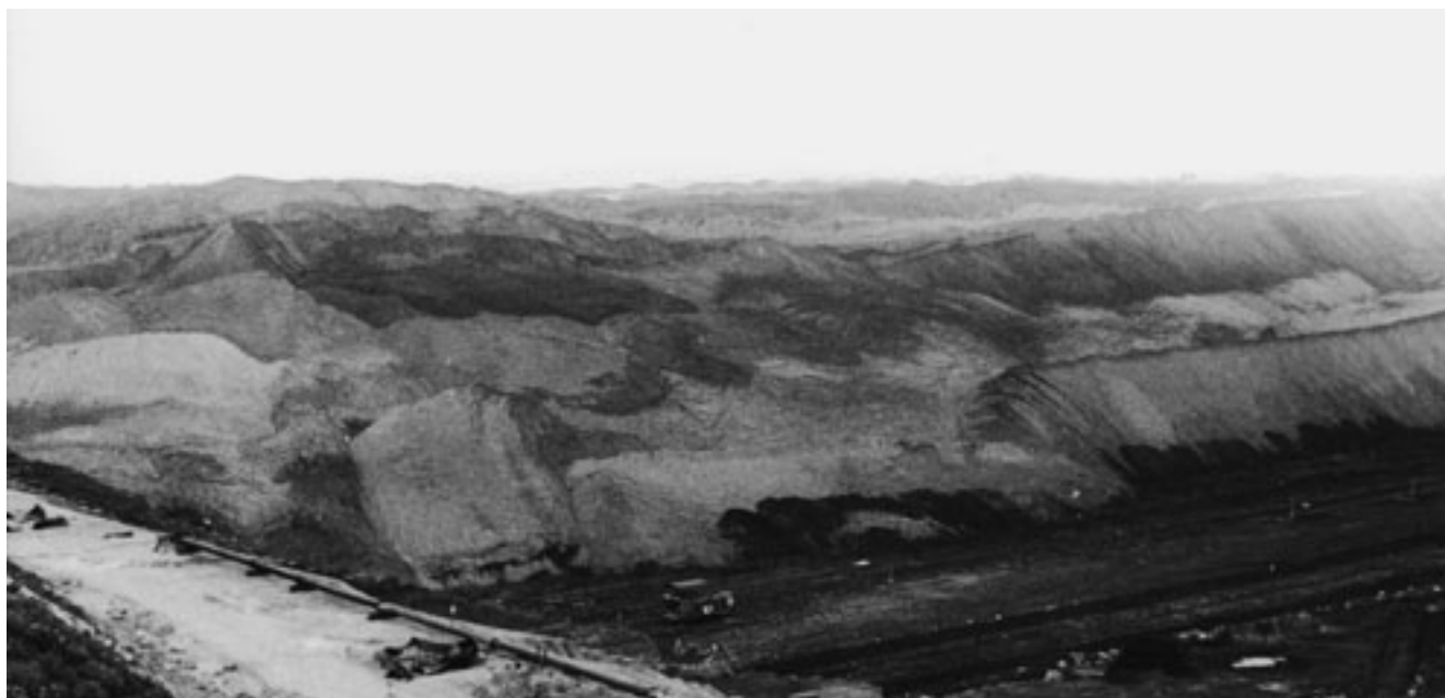
Abb. 2-3-2: Tagebau Zwenkau, Bruch der Stützkippe am Strossenende infolge Massenzusammendrängung auf der Hauptkippe am 29.06.1983
