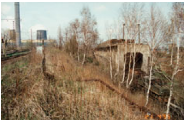
Abb. 5-6-15: Umladebunker Böhlen (Foto: KIRCHHÜBEL)
