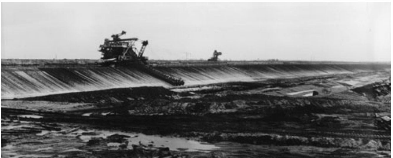
Abb. 5-2-29: Bagger 629 E 1120 im Tagebau Schleenhain
