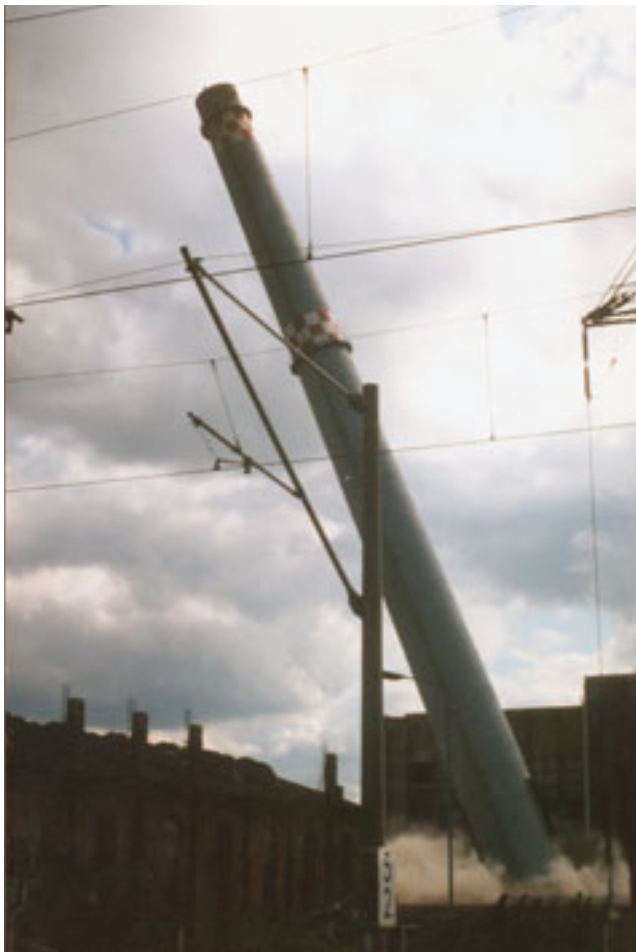
Abb. 5-4-4: Kraftwerk Borna – Schornsteinsprengung am 07.05.1997 (Foto: THIEME)
