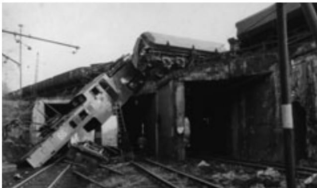
Abb. 7-8-13: Zughavarie im Tagebau Böhlen durch vertauschte Brems- und Kippluftschläuche 1962 (Foto: Archiv Bergamt Borna)
