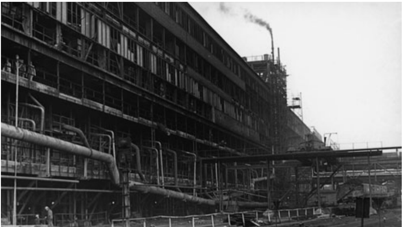
Abb. 5-5-6: Lurgi-Schwefelofenhaus (Gesamtansicht) (Foto: Archiv ZICHEL)
