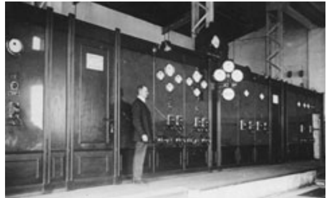
Abb. 5-3-6: Die elektrische Kraftzentrale der Brikettfabrik Deutzen 1913 (Foto: Archiv BRÄUTIGAM)
