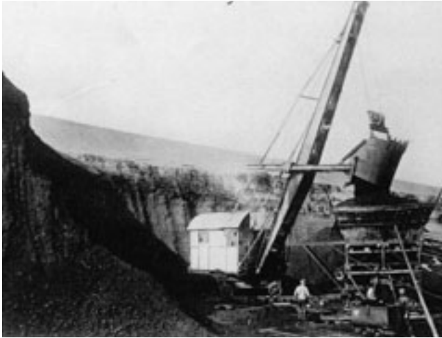
Abb. 5-2-8: Carlshütter Löffelbagger mit Beladetrichter für Kettenbahnuntere (1917) (Foto: Archiv KAPPLER)
