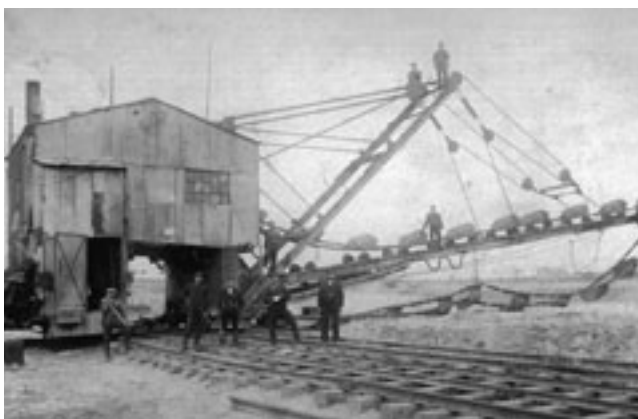
Abb. 4-5-5: Bagger mit Dampfantrieb (um 1900) (Foto: Archiv BRÄUTIGAM)
