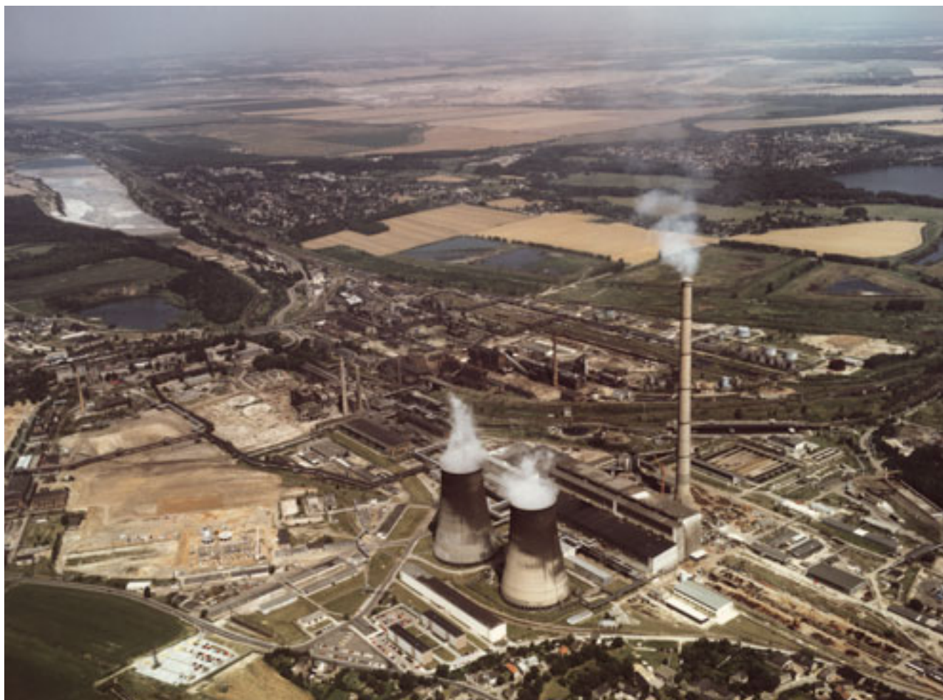
Abb. 5-4-9: Kraftwerk Lippendorf (alt) und Baufeld für das Neubaukraftwerk Lippendorf ca. 1994 (Luftaufnahme HAUSCHILD)
