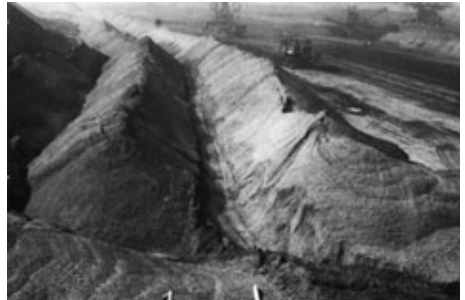
Abb. 2-3-1: Tagebau Zwenkau, zwei wirksame Stützkippen in Strossenmitte, 1985
