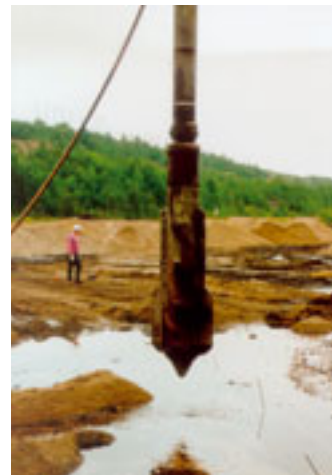
Abb. 5-2-54 : Rütteldruckverdichtung AFB-Kippenfuß Tagebau Espenhain
