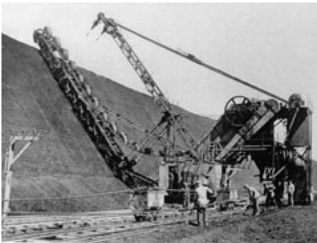
Abb. 5-2-9: LMG-Schrämbagger im Kohlehochschnitt (1917) (Foto: Archiv KAPPLER)
