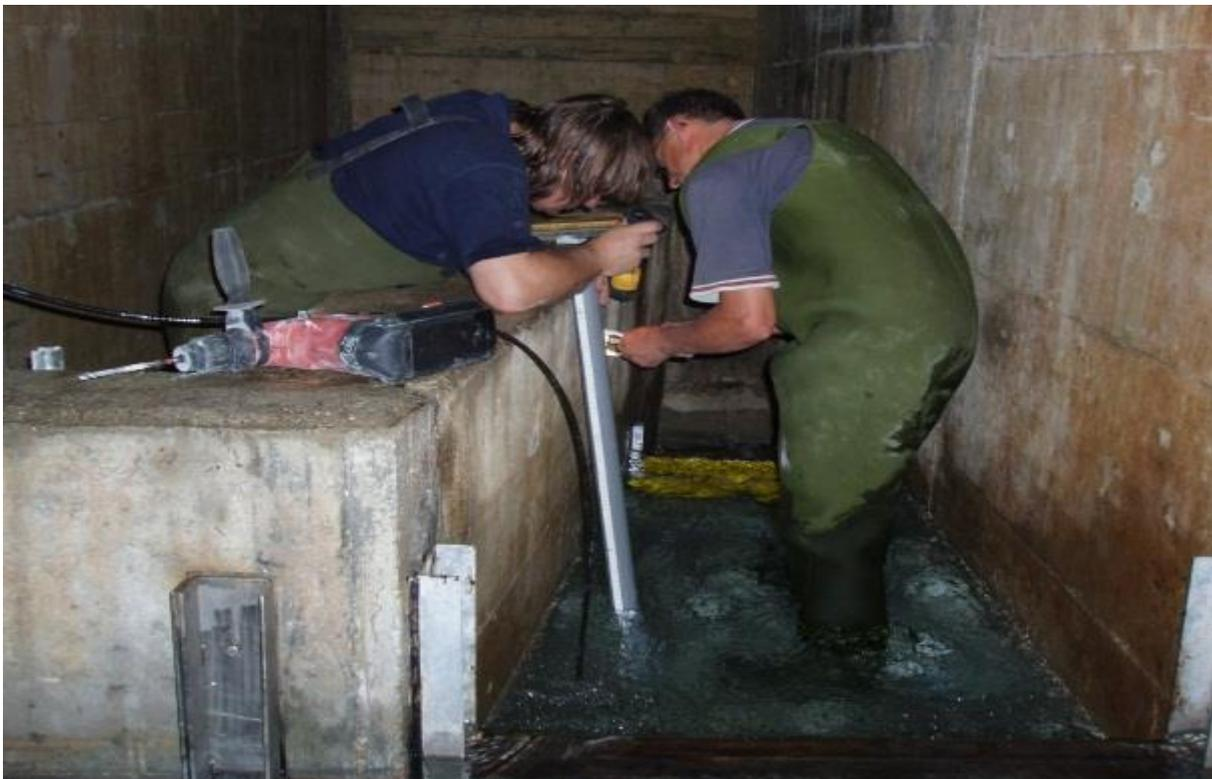
Abbildung 2: Errichtung Messüberfall und Einbau Drucksonde zur kontinuierlichen Registrierung des Wasserstandes
