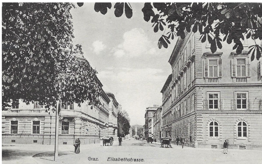
Abb. 3: Häuserfront entlang der Glacisstraße an der Einmündung der Elisabethstraße in Graz, Blick aus der Wilhelm-Fischer-Allee (Stadtpark).
