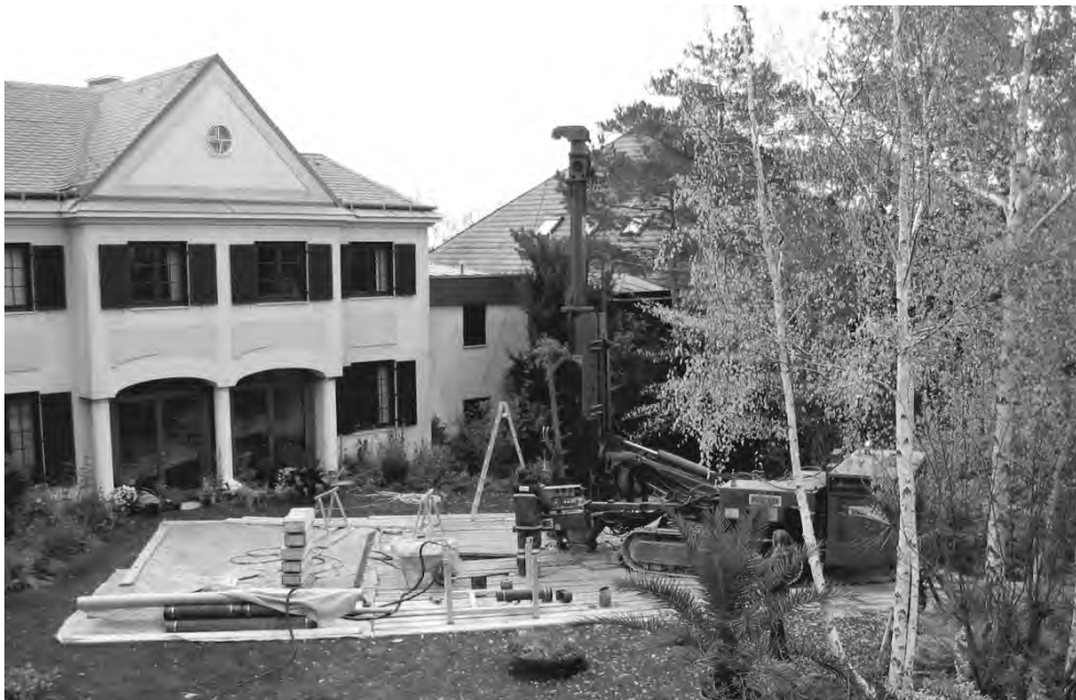
Abbildung 3: Bohrarbeiten im Garten. Projekt Sanierung Marienhöhe.
