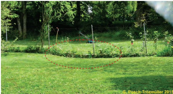
Abbildung 10: Bodensenkung auf einem Grundstück in der Marktgemeinde Hinterbrühl aus POSCH-TRÖZMÜLLER et al. (2015).
