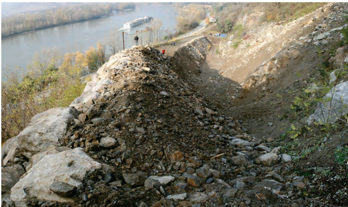
Abbildung 5: Retentionsraum hinter dem Schutzdamm nach erfolgter Ausräumung, Blickrichtung Norden.
