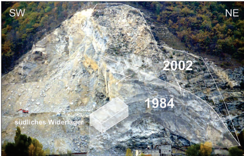
Abbildung 4: Felssturz am 4.10.1984 und beim Ereignis 2002 abgeglittene Felsmassen.
