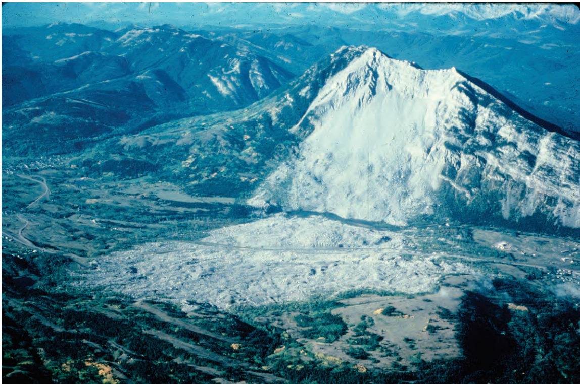
Abbildung 2: Bergsturz „Frank Slide“ (Alberta, Kanada), Abbruchvolumen 36 Mio m 3 (Photo O. Hungr).
