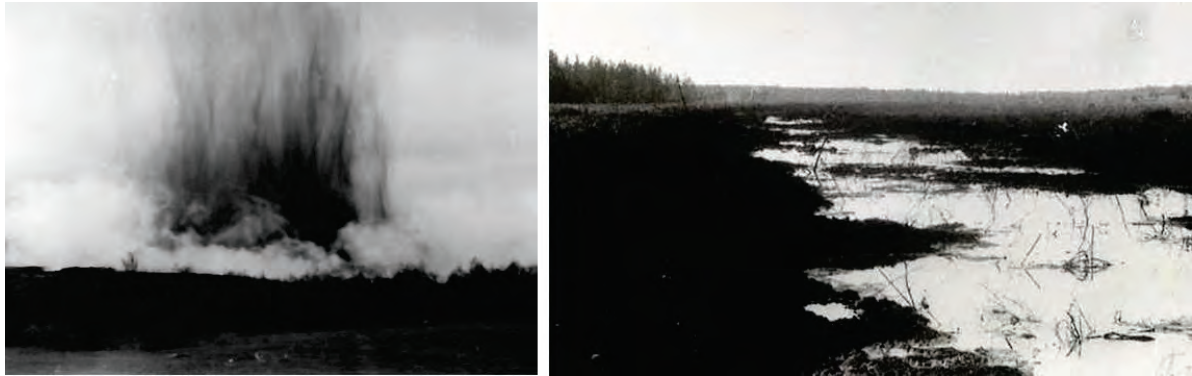
Abb. 7: Links: Sprengung eines Panzergrabens im Moorgebiet von Ssebesch-Idriza. Rechts: Der nach einer Moorsprengung mit Grundwasser gefüllte Panzergraben bildete wegen falscher Wahl der Sprengstellen im Gelände von Ssebesch nur ein lokal begrenztes Hindernis.
