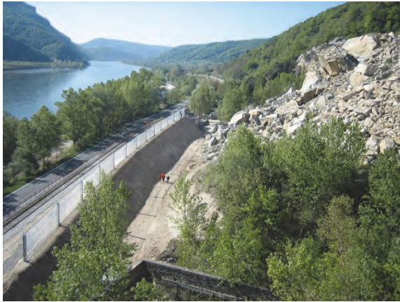
Schutzdamm im April 2007
