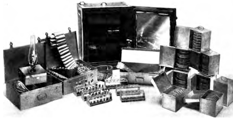
Abb. 2: Bakteriologisches Feldlabor zur Trinkwasseruntersuchung (Schimon, 2004; Reproduktion mit Genehmigung der Redaktion der Österreichischen Militärischen Zeitung).
