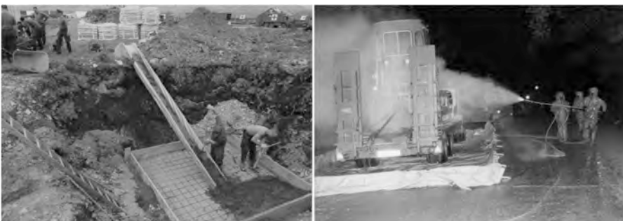
Abb. 22: Beispiele punktueller Abwasserbeseitigung für zivile Zwecke (Aushub einer Senkgrube während des AFDRU-Einsatzes 1999 in der Türkei; links) und Dekontaminierung bei militärischen Einsätzen (rechts; beide Fotos Österreichisches Bundesheer).
