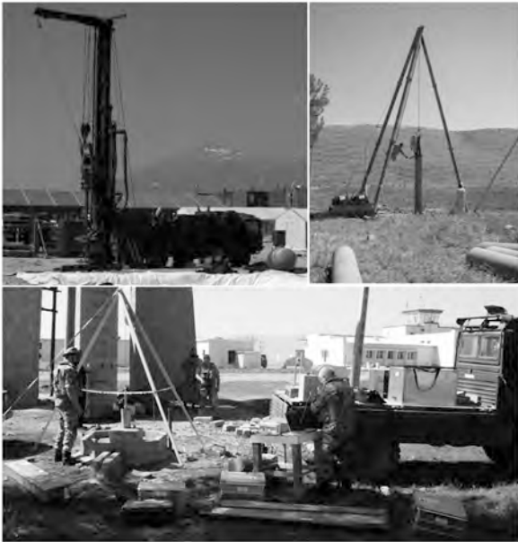
Abb. 19: Grundwassererschließung der Bundeswehr im Ausland. Bohrerät am Flughafen von Prizren (Kosovo, 2002; oben links), behelfsmäßiges Bohrerät für den Brunnenbau in Afghanistan, 2004 (oben rechts) und geophysikalische Bohrlochmessungen am Flughafen von Kunduz (Afghanistan, im April 2004; unten). Aufnahmen aus Willig (2006a; Reproduktion mit Genehmigung der Redaktion Truppendienst).
