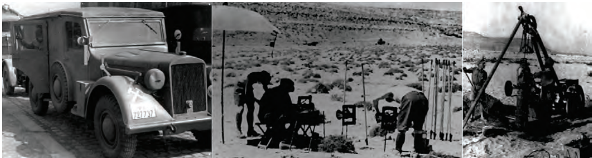
Abb. 11: Im Afrikafeldzug wurde im schweren Geologenwagen (links) geoelektrische Ausrüstung zur Tiefensondierung auf wasserführende und stauende Horizonte mitgeführt (Mitte), deren Erkundungsergebnisse aus Bohrbrunnen Grundwasser für die Trinkwasserversorgung der Truppe lieferten (rechts; Reproduktion der Originalaufnahmen des Leiters der Wehrgeologenstelle 12, Dr. Leo Jakob Medard Kuckelkorn, mit freundlicher Genehmigung von Dr. Kore F. Kuckelkorn, Hannover).
