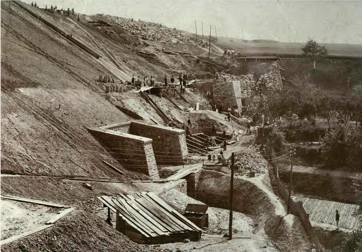
Abb.15: Blick von Nordosten auf die Nordseite der Bahndammschüttung vor 1870. Historisches Foto Krahuletz-Museum.
