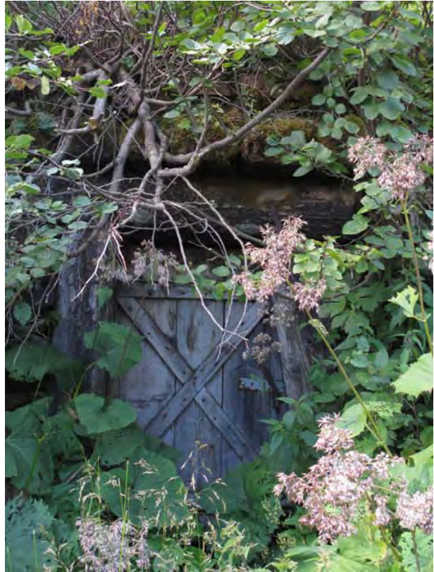
Abb. 49: Mundloch in Schellgaden (Foto: Peter Danner)
