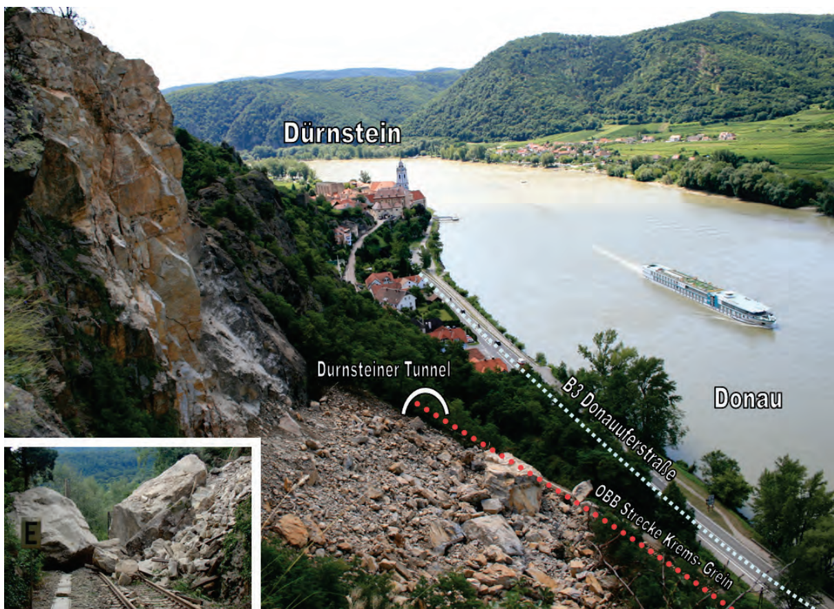
Abb. 1: Felssturz Dürnstein/ Wachau, Niederösterreich
