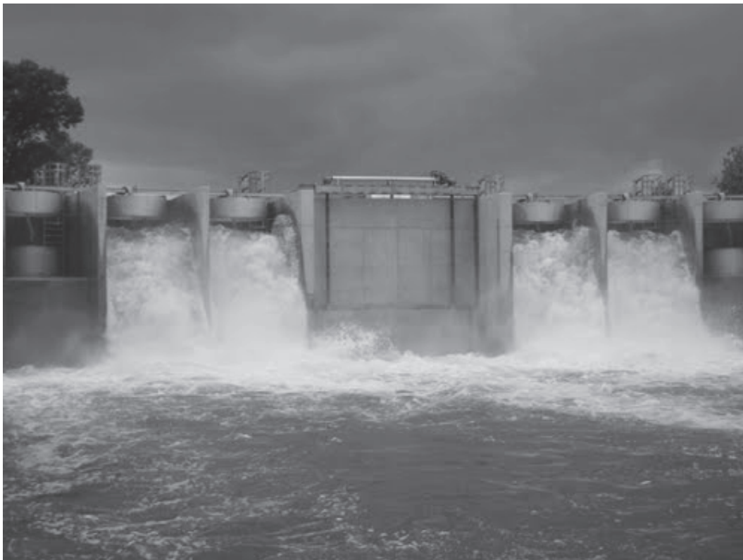
Abb. 10: Pumpwerk Fischamend, Einsatz beim Hochwasser 2011
