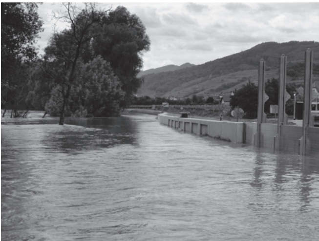
Abb. 7: HWS Weißkirchen, 1. Aufbauphase (Hochwasser 2010)
