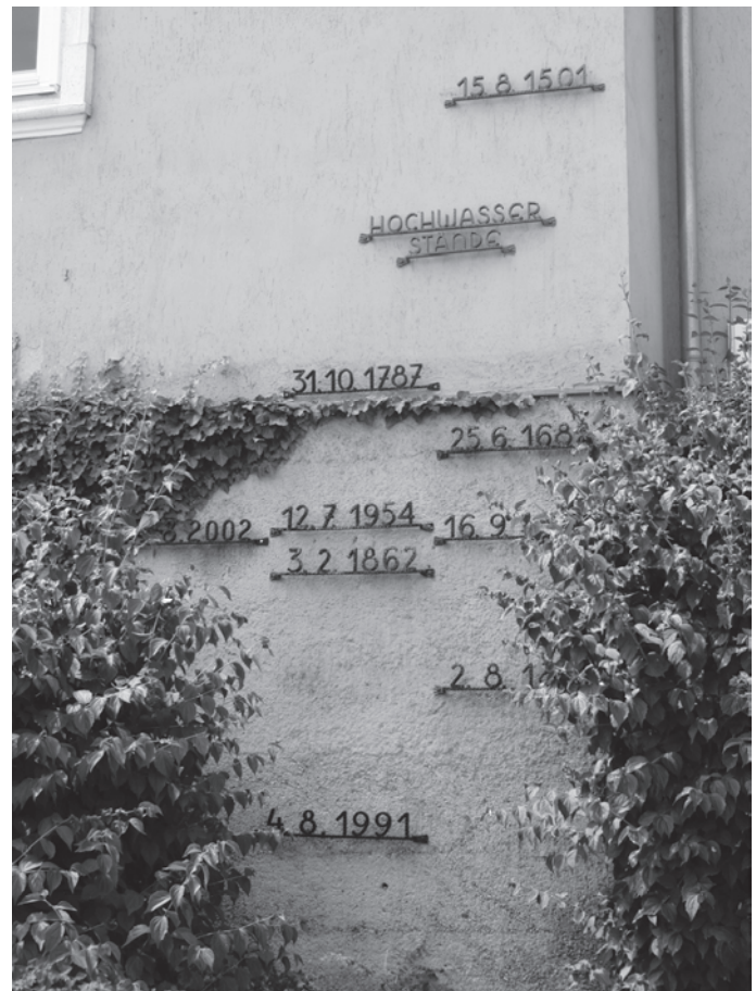
Abb. 2: Historische Hochwassermarken (Ybbs)
