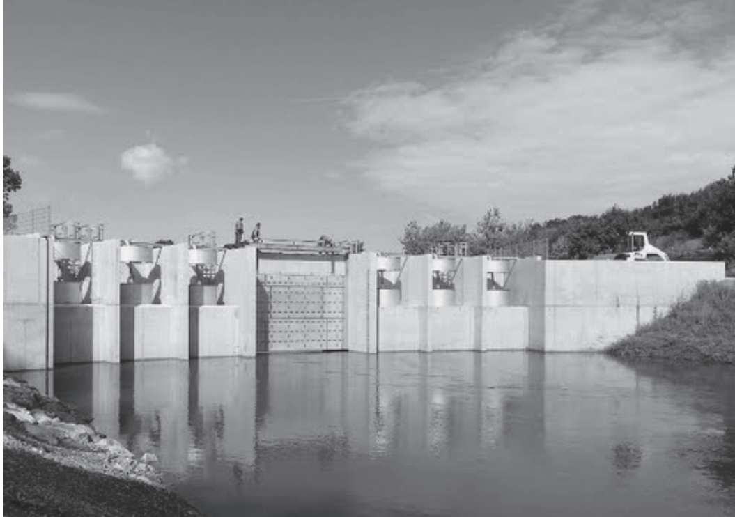
Abb. 9: Pumpwerk Fischamend, Bauphase
