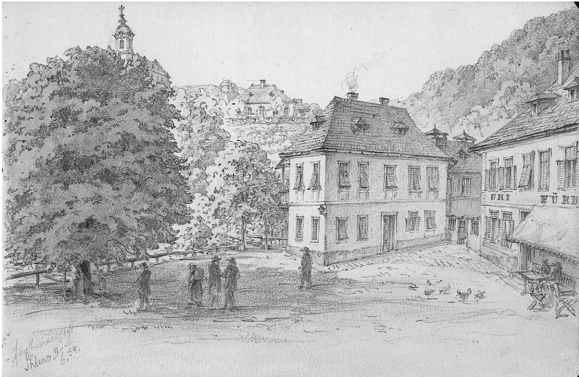
K. L. LIBAY (1814 – 1888): Skleno – Glashütte – Gewerkehäuser, 11. 6. 1884. Vermutlich fand hier der „Workshop“ von 1786 statt. (Archiv W. Vettters)
