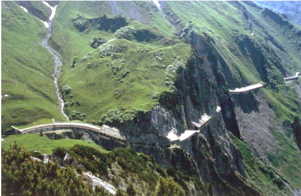
Abb. 3 Flexenstrasse (1897), Bauzustand 1999 (Foto BURGER)
