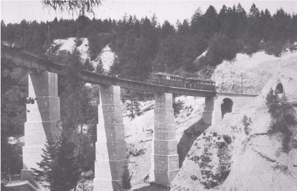
Abb. 2 Stubaitalbahn (1904), Muttener Brücke (aus: BAUMGARTNER 1990)
