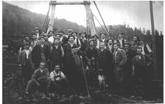
Abb. 2: Unterlaussa. Kohlenbergbau Sandl der Firma Josef Reithoffer's Söhne, Gummi- und Kabelwerke in Steyr. Reparatur der Seilbahn zwischen Bergbau und Unterlaussa/Dörfl. Vorne in Bildmitte: Josef Koestler (mit Bergstock)
