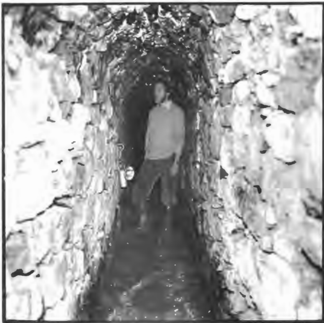
Abb. 11: Johann-Stollen. Im Anfangstrakt ist dieser Stollen mit Trockenmauerwerk abgestützt. Foto B. Baumgarten, 1980.
