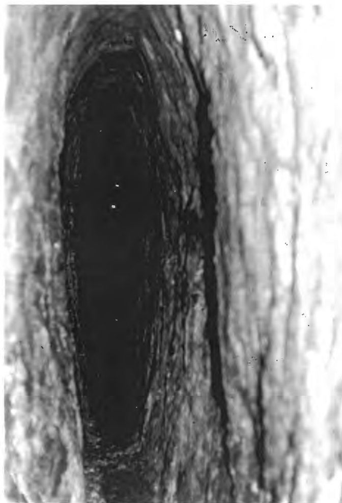
Abb. 6 (= linkes Bild): Martin-Stollen, Anfangstrakt. Im Zuge der Wiedergewältigung wurde das alte Profil (Abb. 7) auf etwa 1,50 m Breite erweitert, wobei die alte rechte Ulme weggesprengt wurde. Foto R. Exel, 1979.
