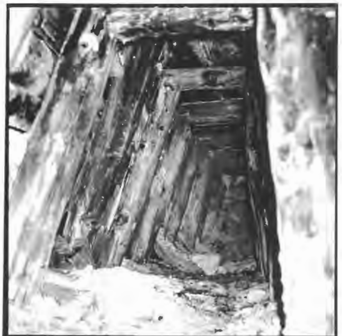
Abb. 12: Johann-Stollen. Alte Holzabstützung. Foto B. Baumgarten, 1980.
