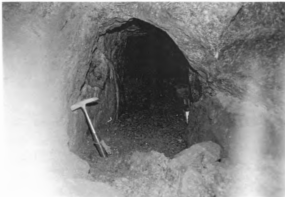
Abb. 14: Bergbau Nals, Stollen Nr. 2. Er wurde mit Schlägel und Eisen, vermutlich im 16. Jht. oder noch früher vorgetrieben. Foto Exel, 1980.
