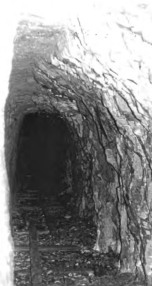
Abb. 6 (= linkes Bild): Martin-Stollen, Anfangstrakt. Im Zuge der Wiedergewältigung wurde das alte Profil (Abb. 7) auf etwa 1,50 m Breite erweitert, wobei die alte rechte Ulme weggesprengt wurde. Foto R. Exel, 1979.
