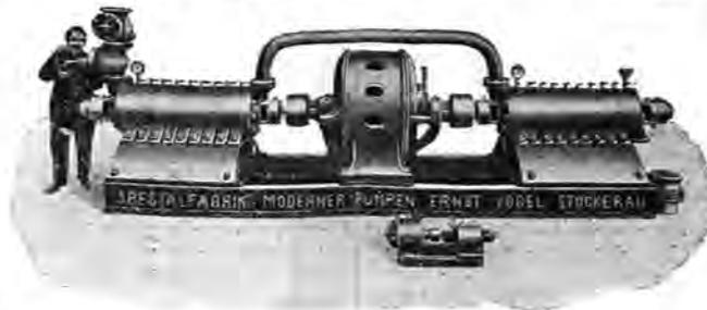
Achtzehnstufige Bergwerks-Turbo-Pumpe, geliefert für 1500 Liter per Minute auf 400 m
