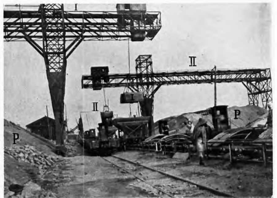
Fig. 17. Verladekrane im Hafen von Tunis. P, P = Phosphathaufen. — B 1 Beltkonveyor. — Der weiter im Vordergrunde stehende Kran I hat sich soeben in den, dem Konveyor aufgesetzten Trichter entleert. — Der Kran II (weiter im Hintergrunde) entleert sich gerade.
