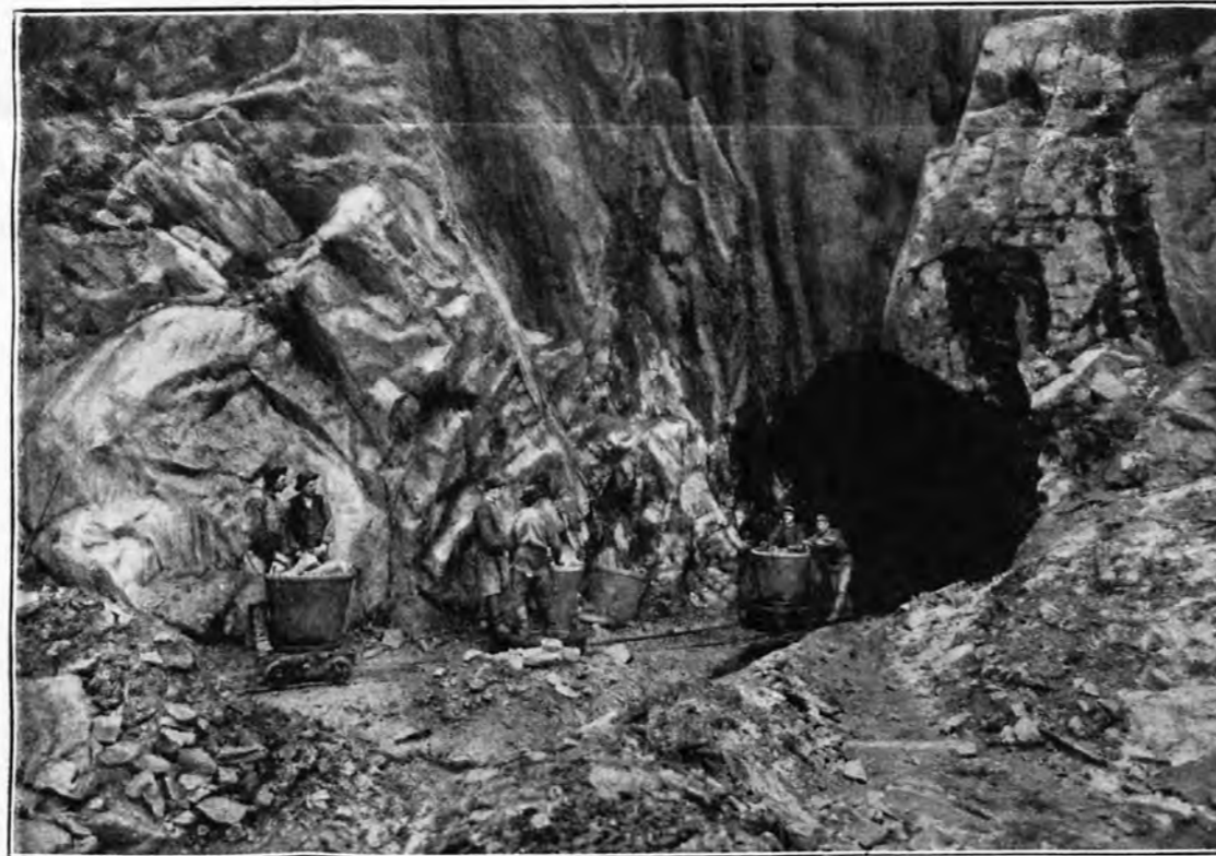
Grube Gängsberg. Tagbau.
