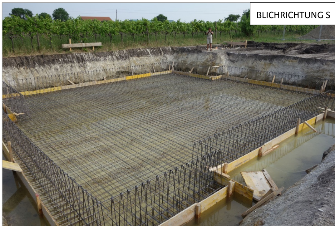
Abb. 2.2.3.11: Aufschlussituation in der Baugrube in Podersdorf am See: Ein schwarzbrauner, in der Mächtigkeit schwankender Bodenhorizont am Top; die Basis bilden hellgraue sandreiche Kiese; (Foto: H. Peresson).
