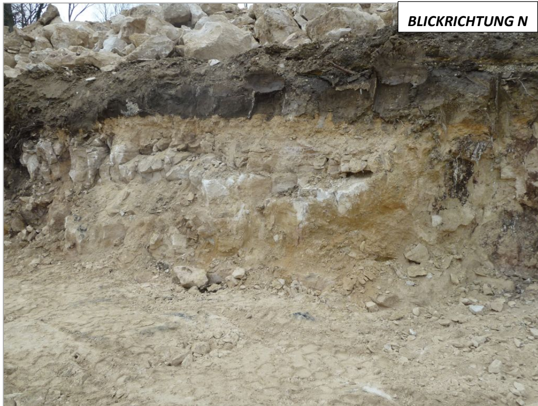
Abb. 2.2.1.4: Baugrube Winden am See: Sehr mächtiger schwarzbrauner Bodenhorizont; unterlagert von rötlichen Kalkareniten, grünlichen Schluffen/Tonen und beigen Kalksteinen (Foto: G. Bieber).
