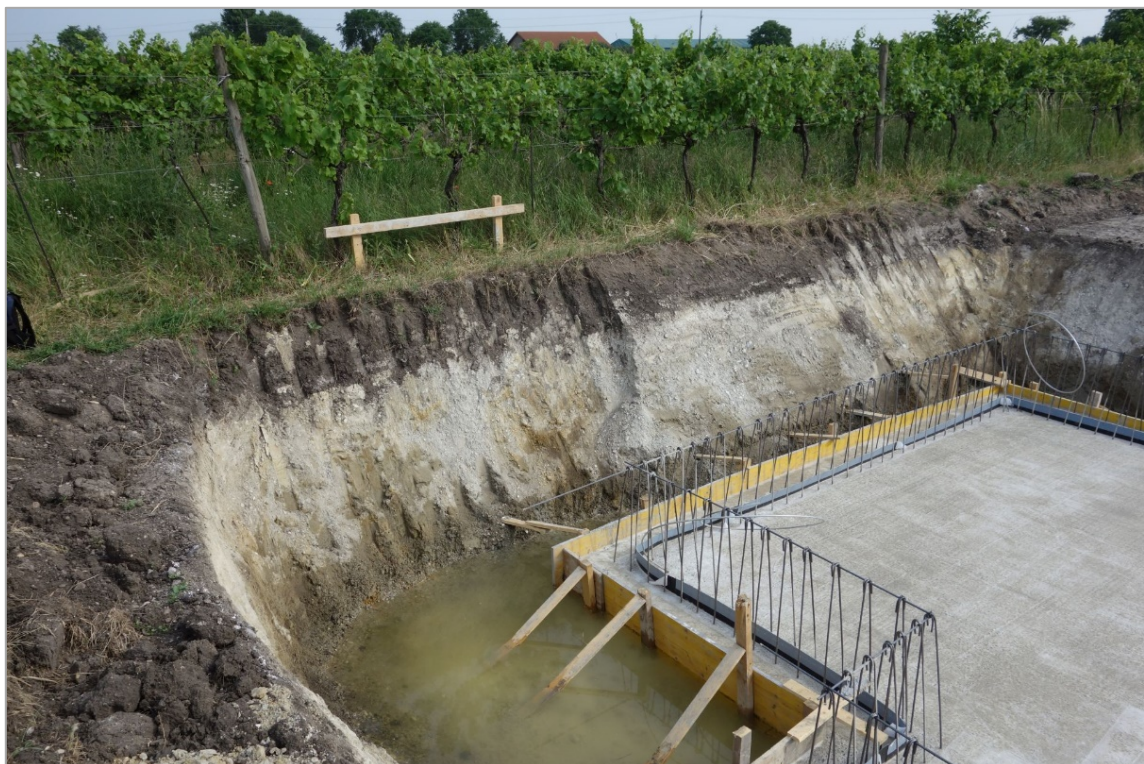
Abb. 2.2.3.8: Aufschlusssituation in der Baugrube in Podersdorf am See: Hangend ein schwarzbrauner Bodenhorizont; im Liegenden hellgraue sandreiche Kiese (Foto: M. Peresson).
