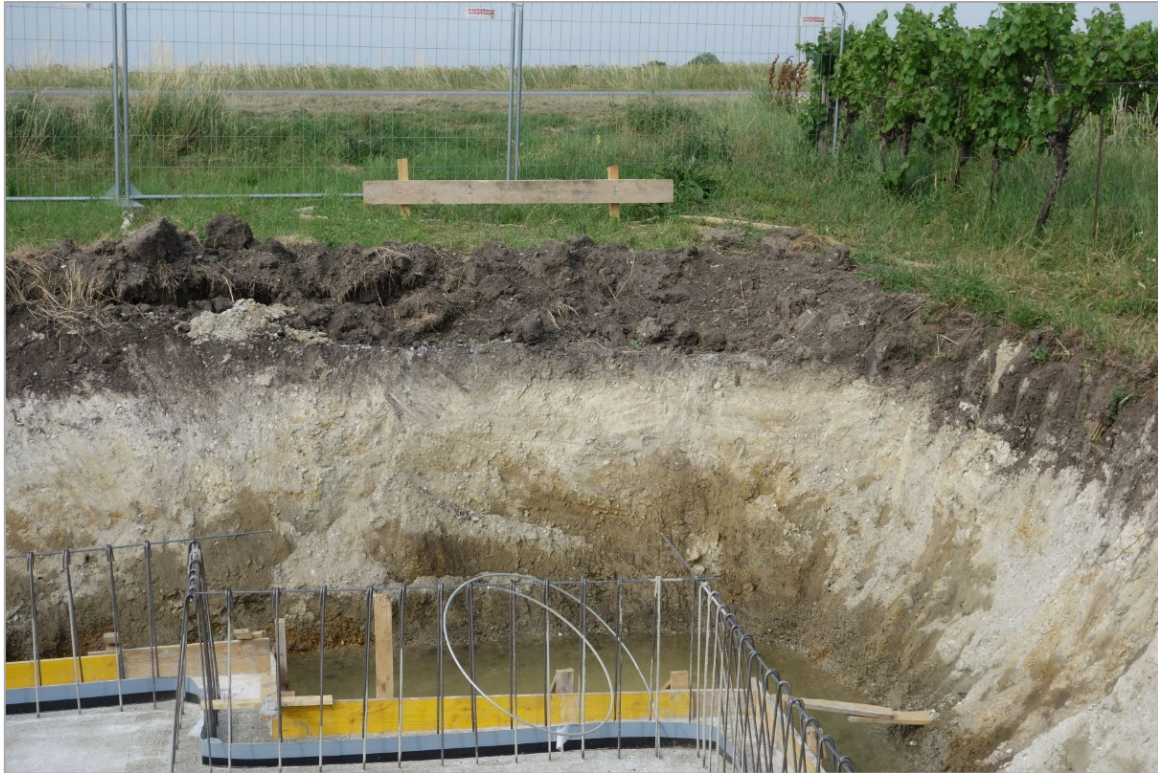
Abb. 2.2.3.9: Aufschlusssituation in der Baugrube in Podersdorf am See: Hangend ein schwarzbrauner Bodenhorizont; im Liegenden hellgraue sandreiche Kiese (Foto: M. Peresson).
