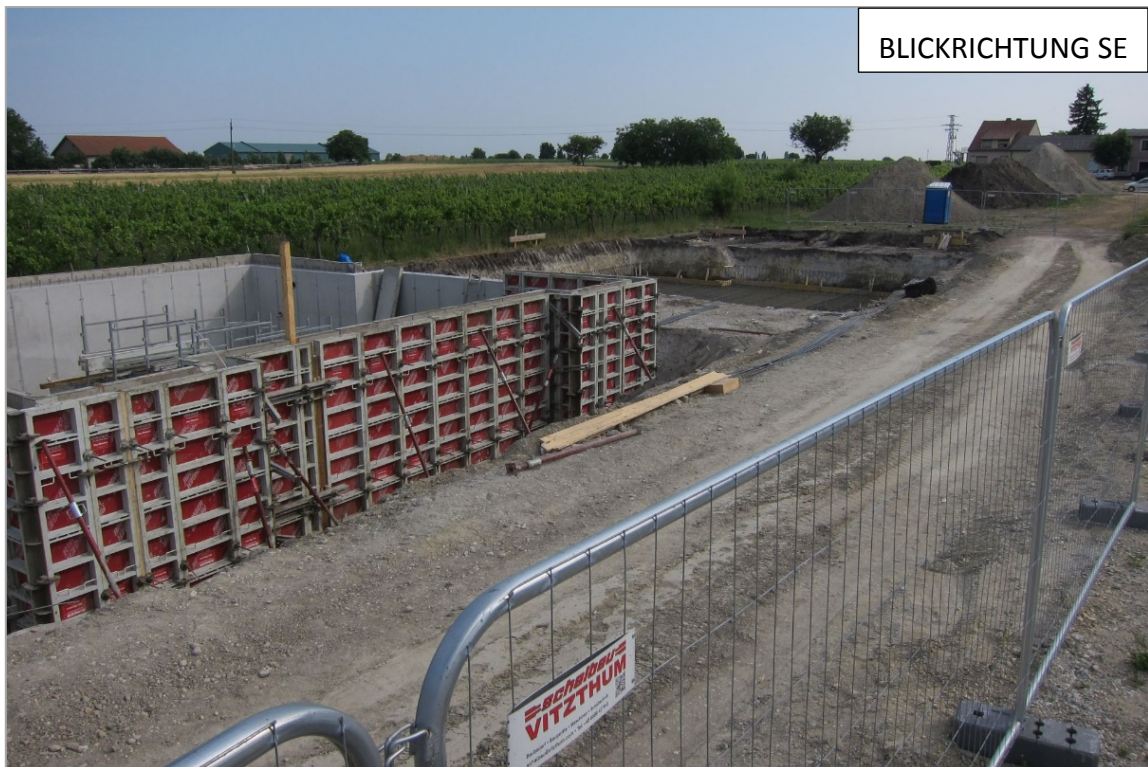
Abb. 2.2.3.7: Überblick über den Bauplatz in Podersdorf am See; südlicher Bauaushub mit fertiggestelltem Kellerbereich (Foto: M. Peresson).
