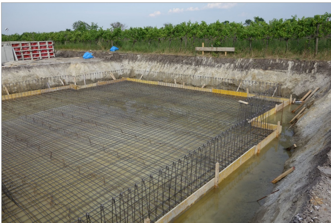
Abb. 2.2.3.10: Aufschlusssituation in der Baugrube in Podersdorf am See: Ein schwarzbrauner Bodenhorizont im Hangenden, der unterlagert wird von hellgrauen sandreiche Kiesen; im gesamten Baustellengelände steht Wasser in den Gruben (Foto: M. Peresson).
