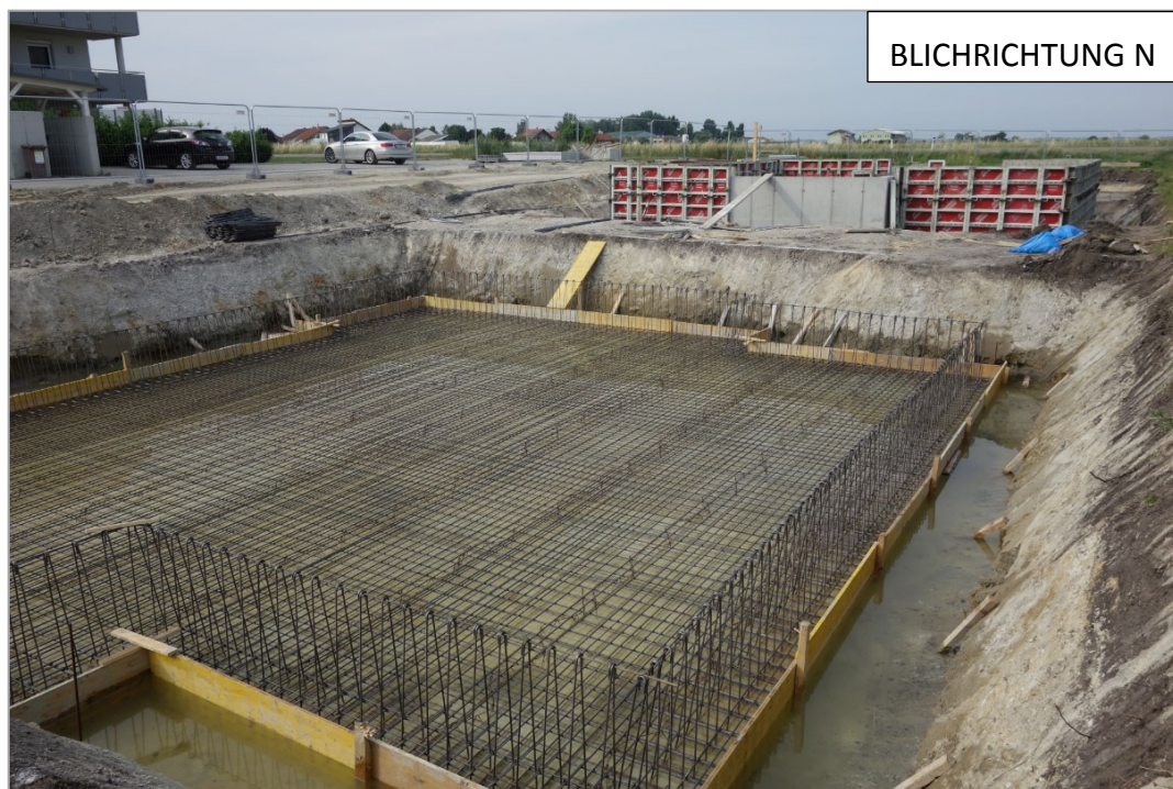
Abb. 2.2.3.12: Aufschlussituation in der Baugrube in Podersdorf am See: Ein schwarzbrauner, teilweise auskeilender Bodenhorizont am Top; im Bereich der Grubensohle hellgraue sandreiche Kiese; (Foto: H. Peresson).
