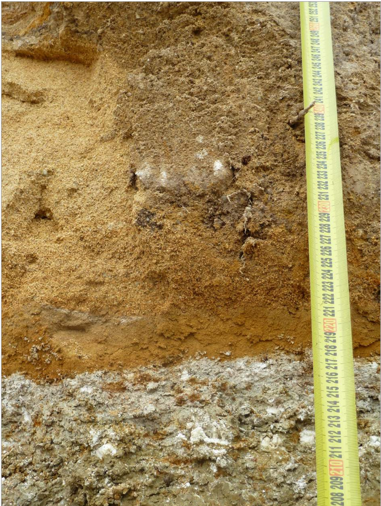
Abb. 2.2.1.6: Baugrube Winden am See: Detailfoto des rotbraunen Kalkarenites im Grenzbe- reich zum grünlichen Schluff/Ton (Foto: G. Bieber).
