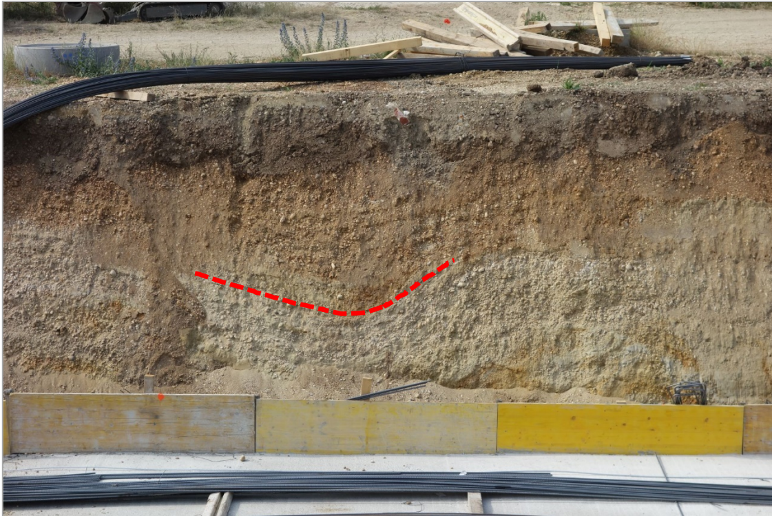
Abb. 2.2.2.16: Detailfoto in der Baugrube in Neusiedl am See: Rinnenbildung (rot strichliert) innerhalb der rötlichen Kiese und distinkter Lagenbau mit Gradierung in den gelblichen Kiesen (Foto: M. Peresson).
