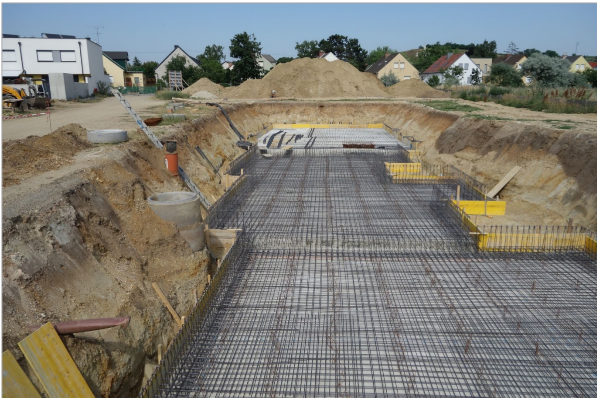
Abb. 2.2.2.9: Überblick Baugrube „Reihenhausanlage in Neusiedl am See“: dunkelbrauner Bodenhorizont mit Kieseinstreu im Hangenden, unterlagert von rötlichbraunen sandreichen Kiesen (Foto: H. Peresson).
