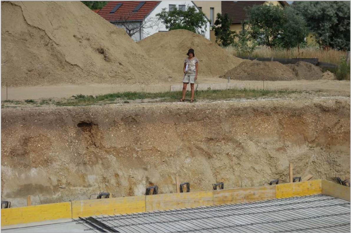
Abb. 2.2.2.10: Baugrube in Neusiedl am See: Im Hangenden ein wellig ausgebildeter dunkelbrauner Bodenhorizont; im Liegenden sandreiche rötliche, unsortierte Kiese und gelblichbraune sandreiche Kiese (Foto: H. Peresson).
