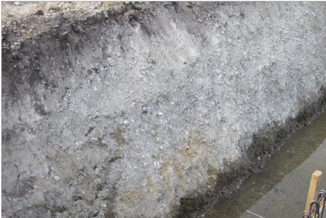
Abb. 2.2.3.14: Detailfoto in der Baugrube in Podersdorf am See: Chaotisch abgelagerte, hellgraue, sandreiche Kiese; bereichsweise gelblich verfärbt; (Foto: M. Peresson).
