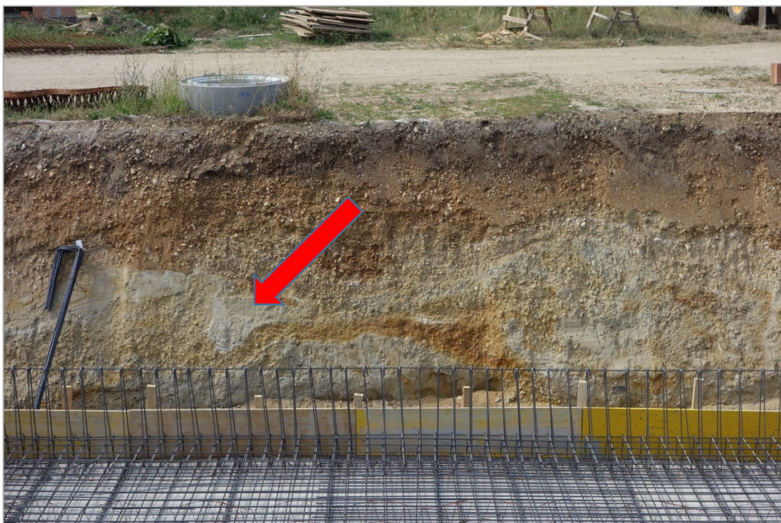
Abb. 2.2.2.15: Aufschlussituation in der Baugrube in Neusiedl am See: Entwässerungsstruktur innerhalb der gelbgrauen, sandreicheren Kiese (Foto: H. Peresson).
