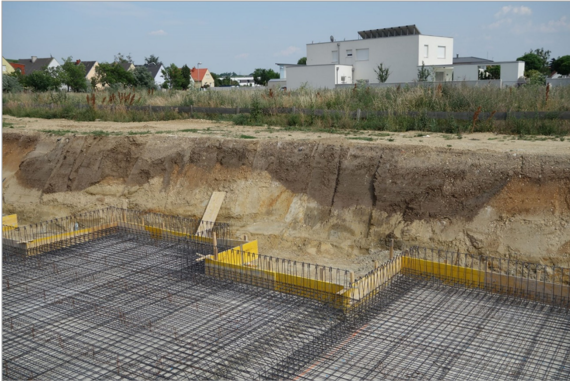
Abb. 2.2.2.14: Baugrube in Neusiedl am See: Wellig ausgebildeter dunkelbrauner Bodenhorizont im Hangenden (Foto: M. Peresson).
