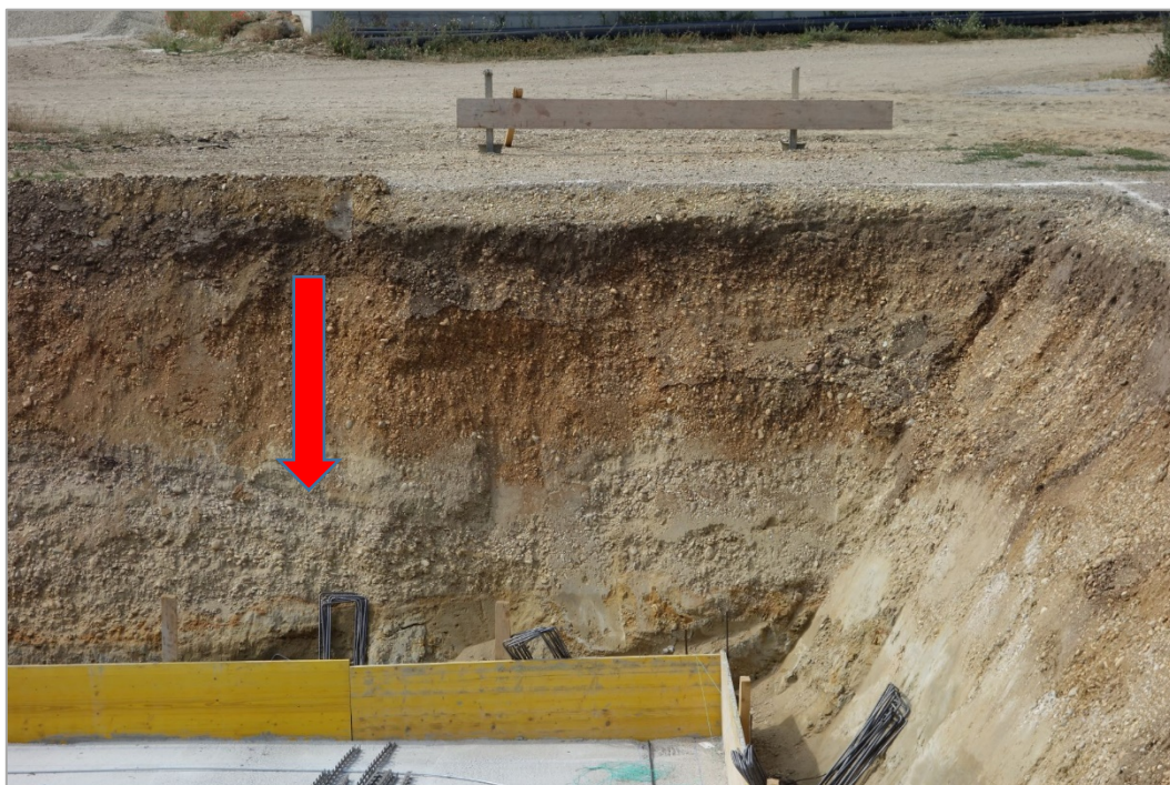
Abb. 2.2.2.17: Detailfoto in der Baugrube in Neusiedl am See: Deutlich erkennbar ist eine Schrägschichtung innerhalb der Kiese („gravel bar“ Sedimente) (Foto: M. Peresson).
