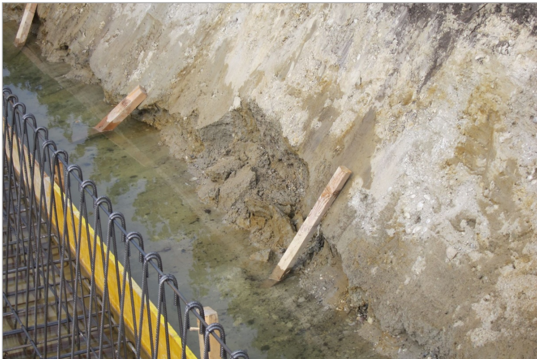
Abb. 2.2.3.15: Detailfoto in der Baugrube in Podersdorf am See: Chaotisch abgelagerte, hellgraue, sandreiche Kiese im Hangenden; zur Grubensohle wird das Sediment Sand-dominiert (Foto: M. Peresson).
