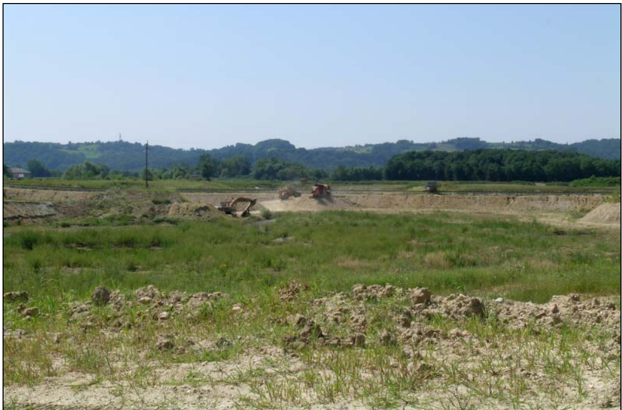
Abb. 110: Schotterwerk Holler, Blickrichtung Königsdorf (02/08/2005)
