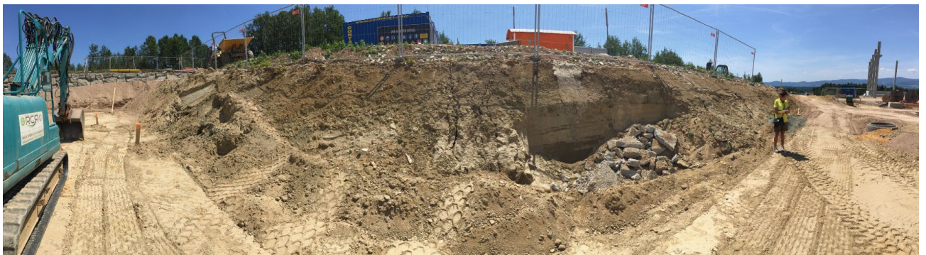
Abb. 2.2.1.8.: Baugrube für eine Lagerhalle westlich von Pinkafeld: Bearbeiteter Hanganriss an der Südseite des Baustellengeländes (Foto: M. Peresson).
