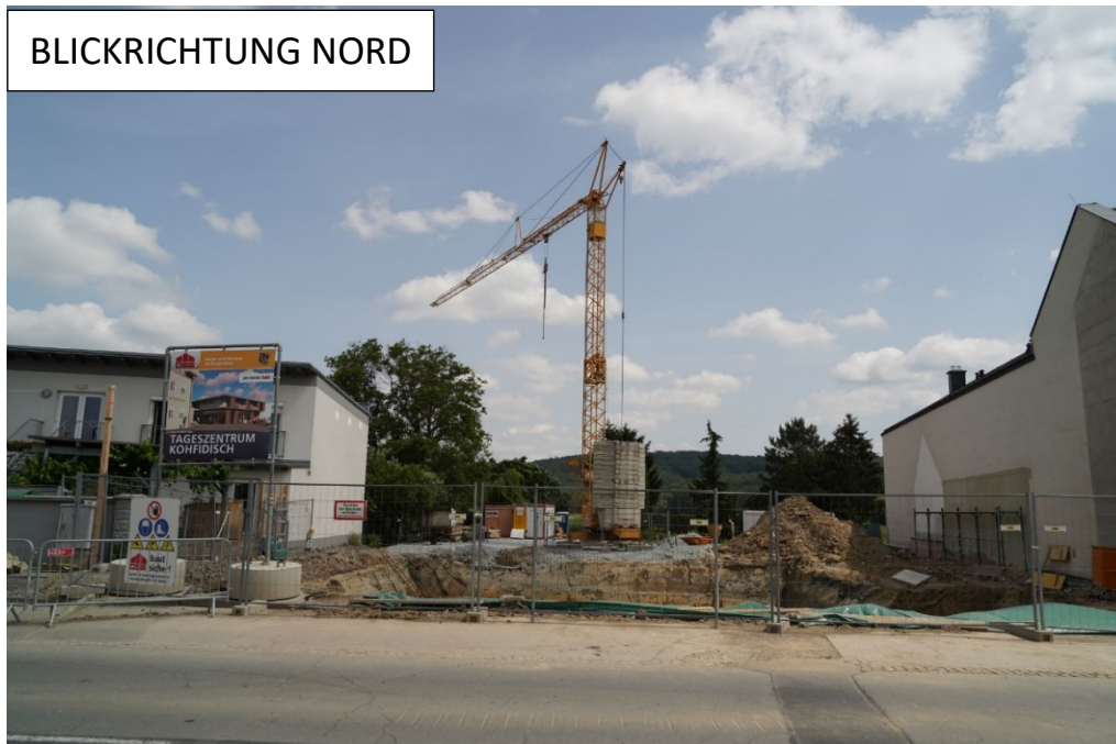
Abb. 2.3.1.9.: Baustelle für ein Tageszentrum in Kohfidisch: Überblicksaufnahme (Foto: M. Peresson).
