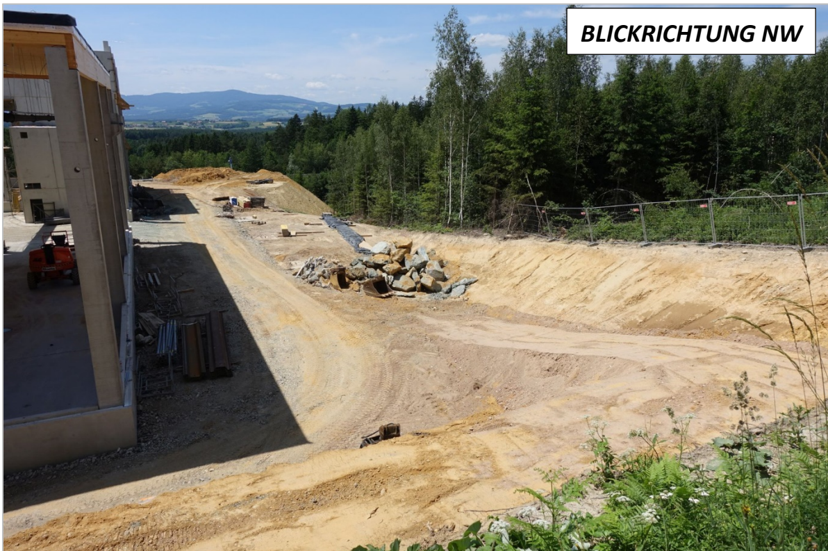
Abb. 2.2.1.14.: Baugrube für eine Lagerhalle westlich von Pinkafeld: Hanganriss an der Nord- seite des Baustellengeländes; Material wurde planiert und verschoben; Dokumentation an dieser Seite war nicht mehr möglich (Foto: M. Peresson).
