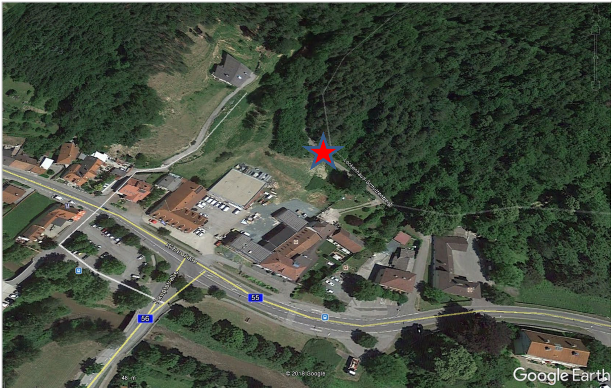
Abb. 2.4.1.2.: Luftbildaufnahme des Baustellengeländes in Lockenhaus am Schüttenberg (Quelle: Google Earth)
