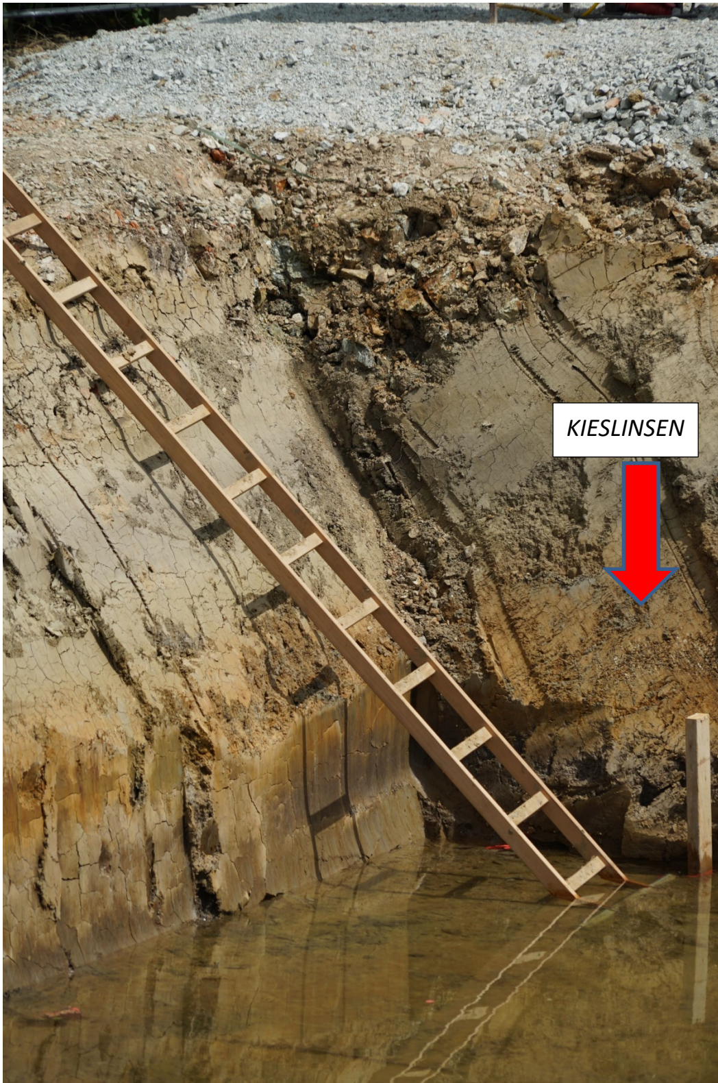
Abb. 2.3.1.16.: Baustelle für ein Tageszentrum in Kohfidisch: Abfolge aus Schluffen und Tonen in wechselnden Farbnuancen – Überflutungssedimente; innerhalb der rötlichen Schluffe Einschaltungen von Kieslinsen (Foto: M. Peresson).
