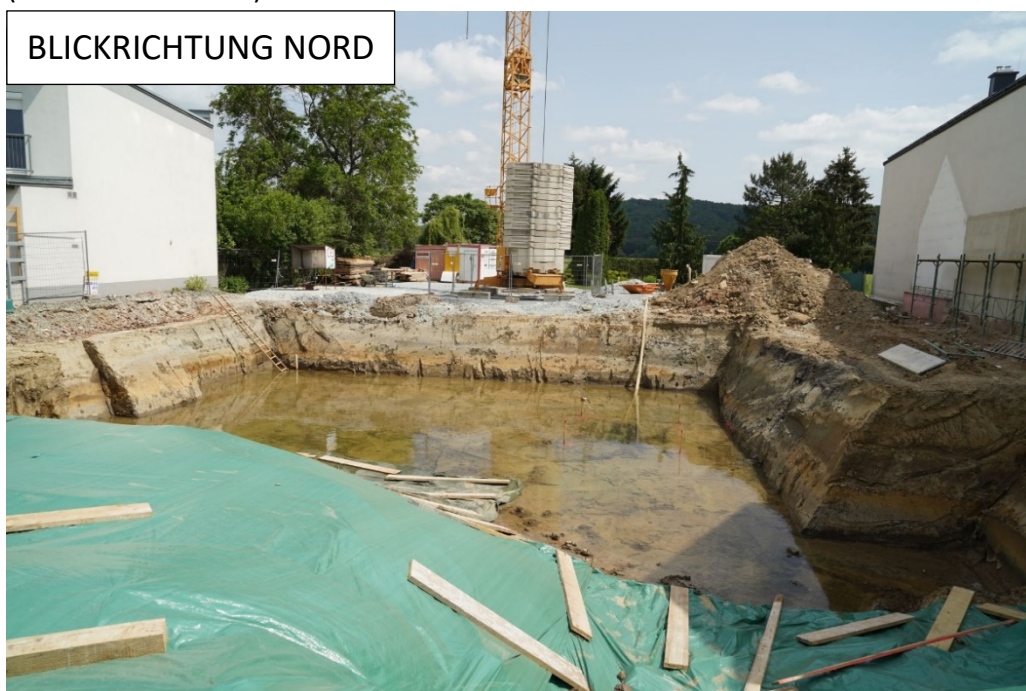
Abb. 2.3.1.10.: Baustelle für ein Tageszentrum in Kohfidisch: Überblicksaufnahme (Foto: M. Peresson).
