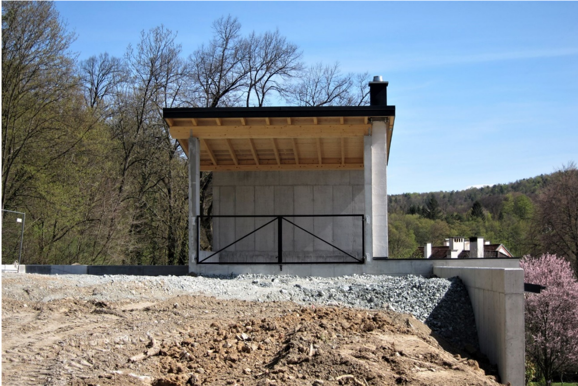
Abb. 2.4.1.4.: Baugelände im Bereich des Güterweges Schüttenberg in Lockenhaus (Foto: M. Peresson)
