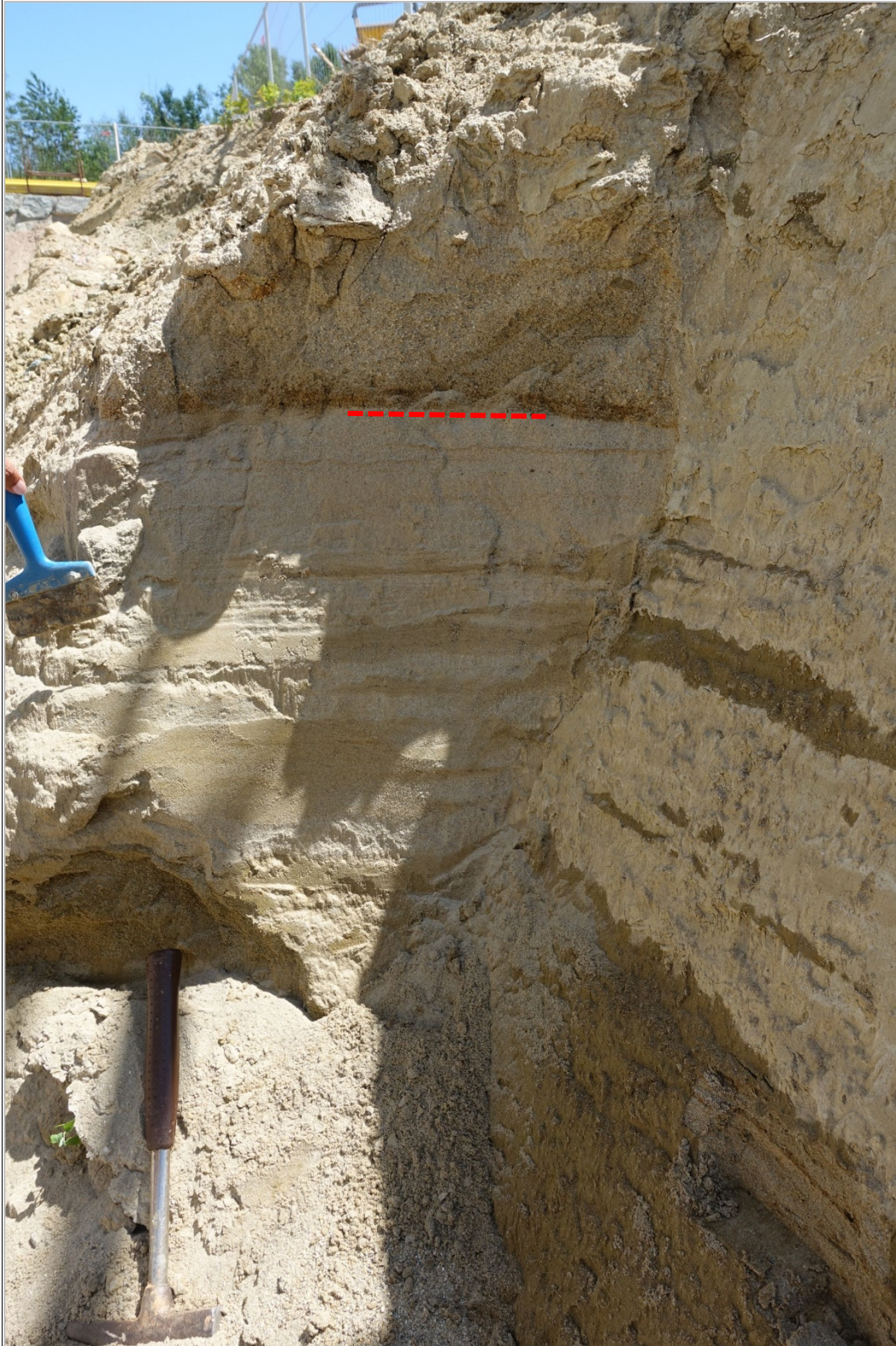
Abb. 2.2.1.10.: Baugrube für eine Lagerhalle westlich von Pinkafeld: Hanganriss an der Südseite des Baustellengeländes; laminierte, schluffige Feinsande an der Basis der Wand; Übergang zu Grobsanden (strichliert) im Hangenden deutlich erkennbar (Foto: M. Peresson).
