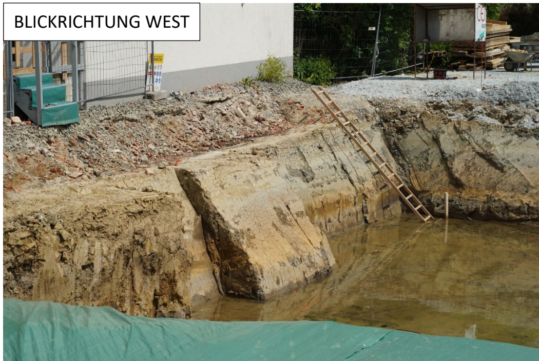
Abb. 2.3.1.11.: Baustelle für ein Tageszentrum in Kohfidisch: Abfolge aus Schluffen und Tonen in wechselnden Farbnuancen - Überflutungssedimente (Foto: M. Peresson).
