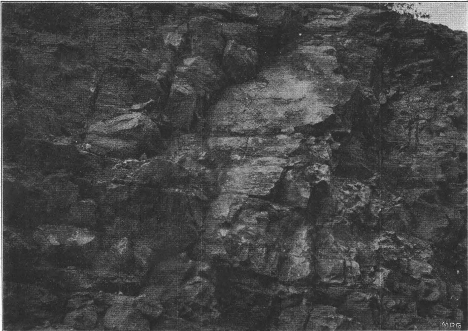
Figur 7. Gleitfläche in den Pseudomutabiliskalken. Einschnitt nächst der Fuchsmühle im Möhrenbachtal bei Treuchtlingen.
