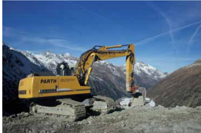
Mit dem Bau des "Notweges", wurde das wilde Griefstal im hinteren Pitztal schwer in Mitleidenschaft gezogen.
