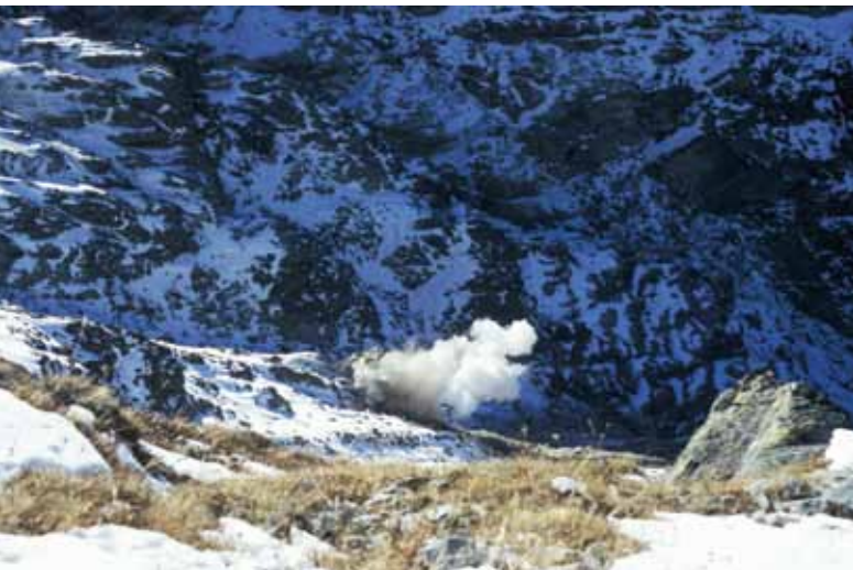
Der "Notweg" musste in das überaus steile Gelände regelrecht hineingesprengt werden.
