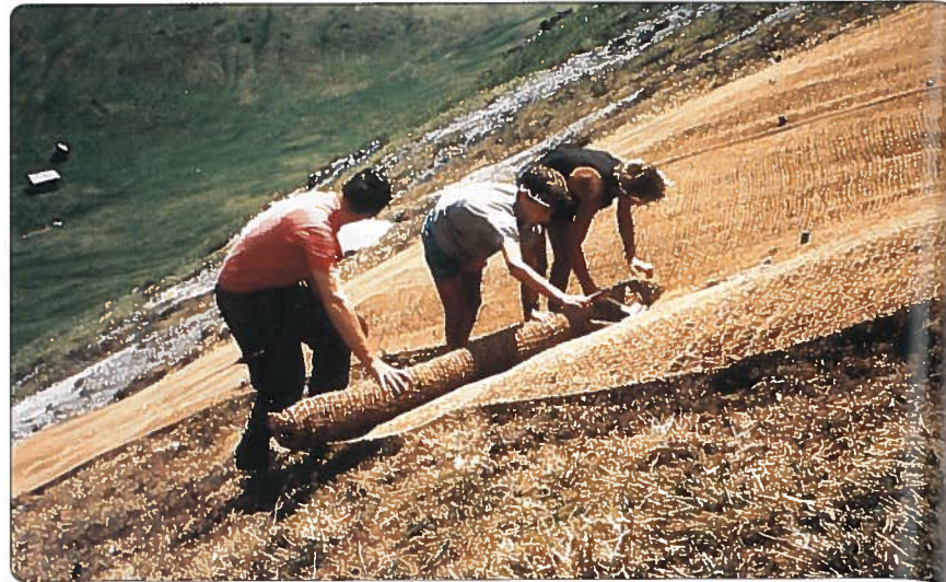
Bodenschutzmaßnahmen im Rahmen einer Umweltbaustelle der OeAV-Sektion Matre Brenner am Blaser/Tirol.
