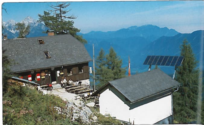
Der Alpenverein fördert die Alternativenergie auf den Alpenvereinshöfen - Photovoltaikanlage auf der Zeller Hütte/Totes Gebirge.
