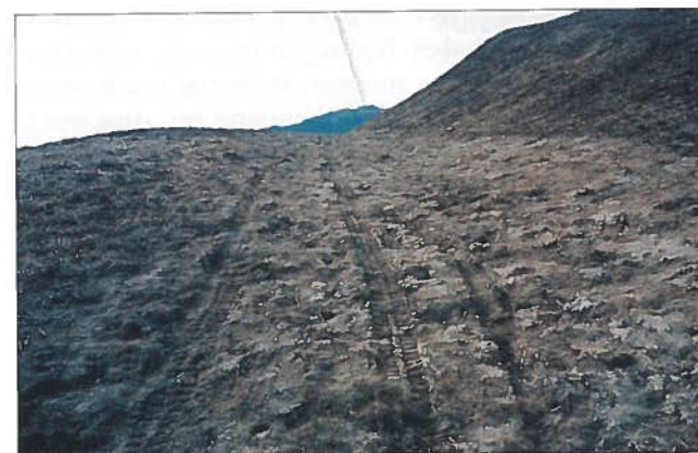
Die Vegetationsdecke wurde nicht wie im Bescheid vorgeschrieben wieder vorsichtig aufgelegt sondern einfach einplaniert.
