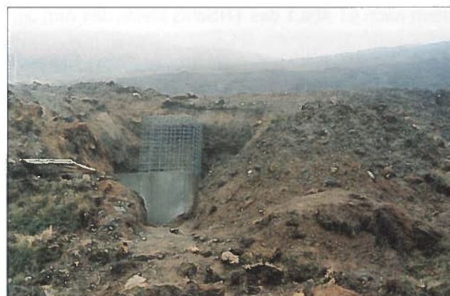
Die Errichtung von Liftstützen erfordert massive Geländeingriffe.
