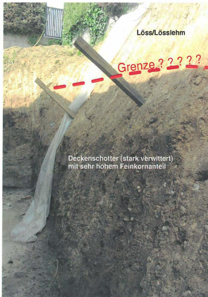
Abb. 4.1: stark verwitterte Deckenschotter mit geringer Löss/Lösslehmbedeckung (Baugrube in Oberwolfen)
