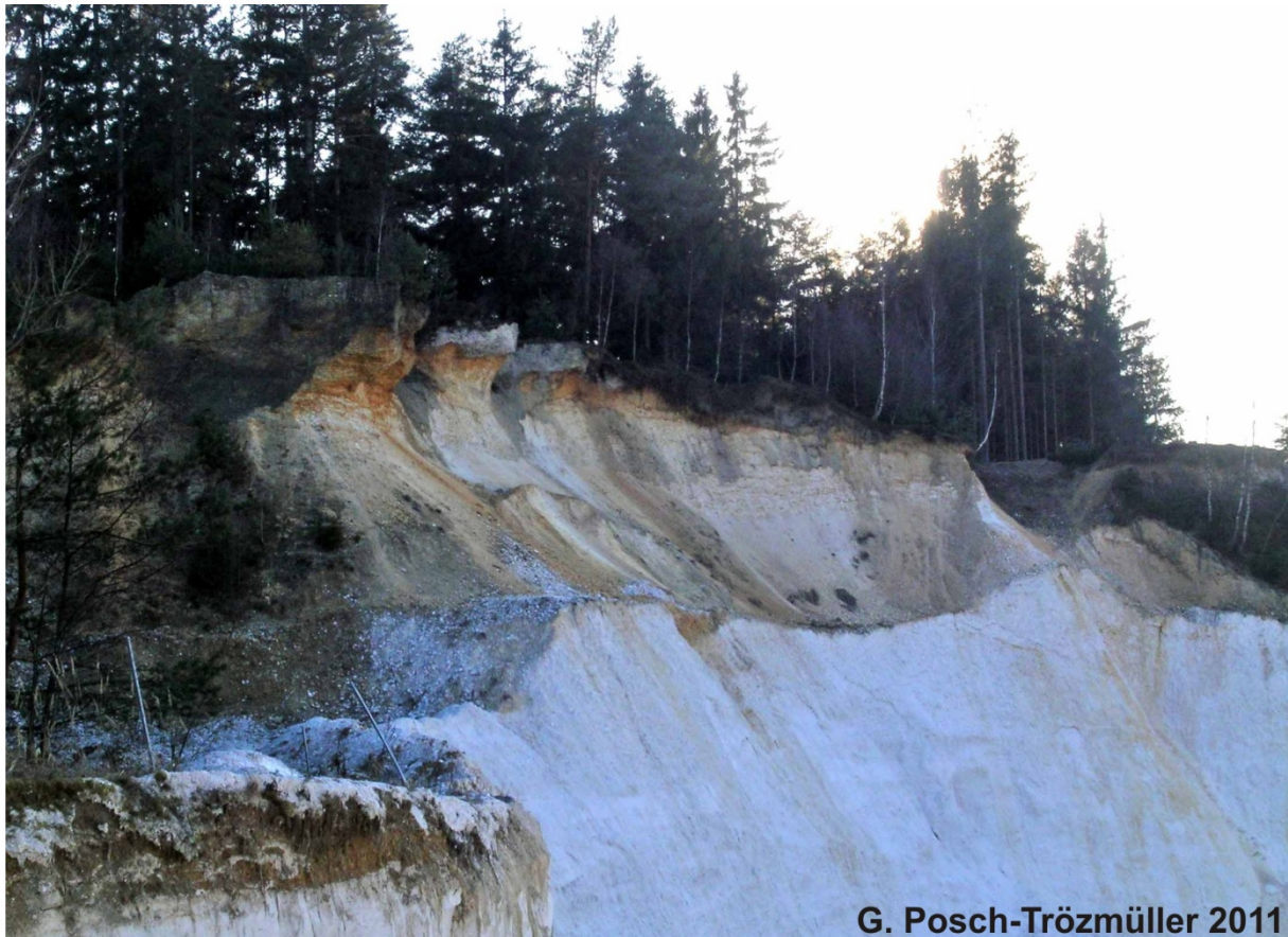
Abb. 2.2.32.: Blick auf die S-Wand der Kiesgrube: Deutlich sichtbar sind die Überhängenbildenden konglomerierten oberen Schichten der Kiese, die eine rostrote Verfärbung aufweisen.
