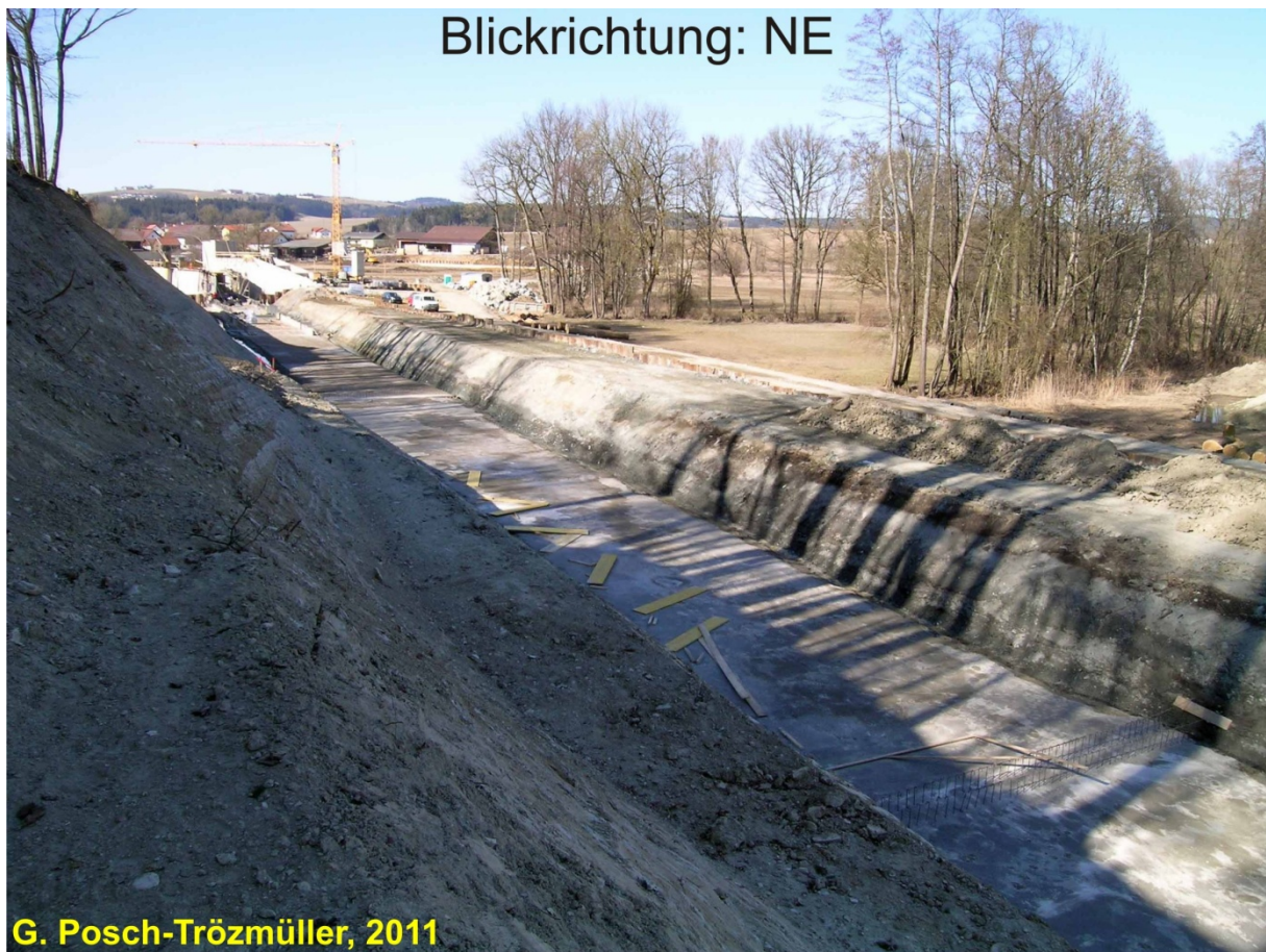
Abb. 2.2.3.: Blick von der Aufschlusswand Richtung NE-N über die Baustelle.
