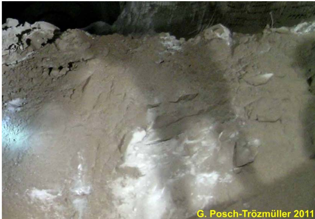
Abb. 2.1.17.: Detailaufnahme von Haselgebirgsaufschlüssen in einem Querschlag etwa bei Tunnelmeter 970.
