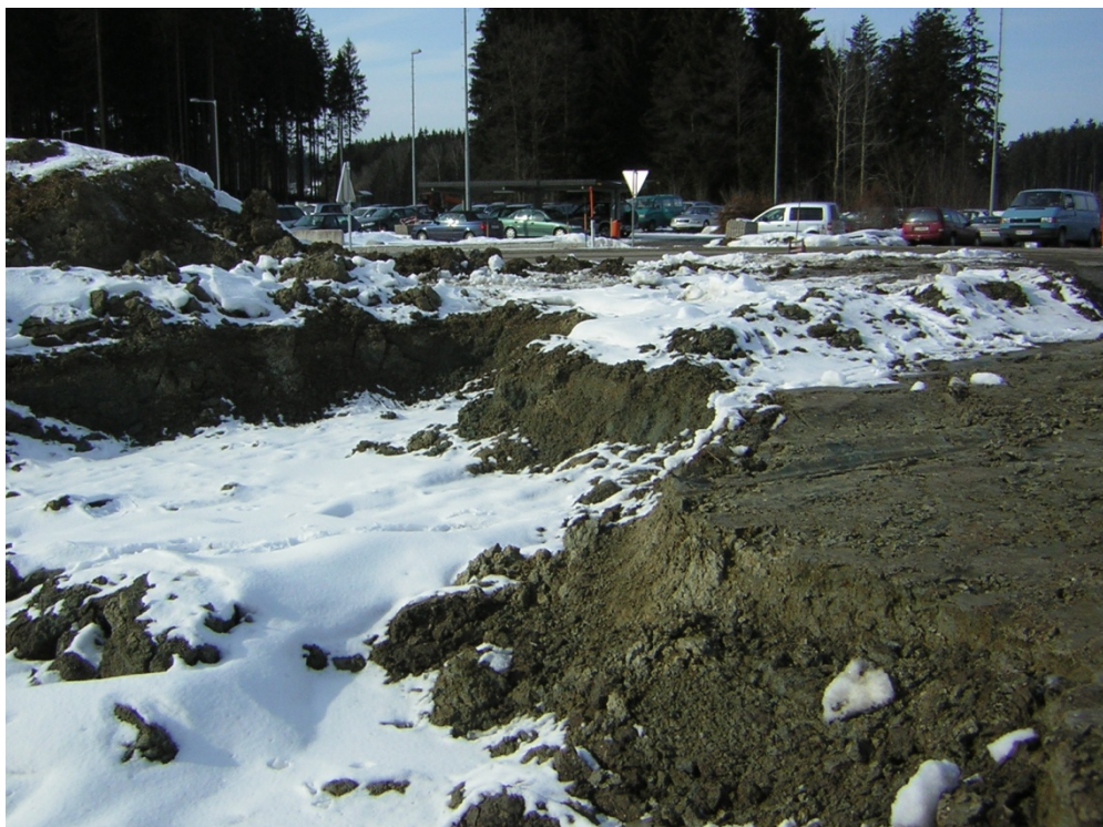
Abb. 2.3.8.: Baustelle Kleinzell im Mühlkreis: dunkelgraue bis braune sandige Schluffe und Tone (März 2010, Elfriede Ruprecht-Porod).
