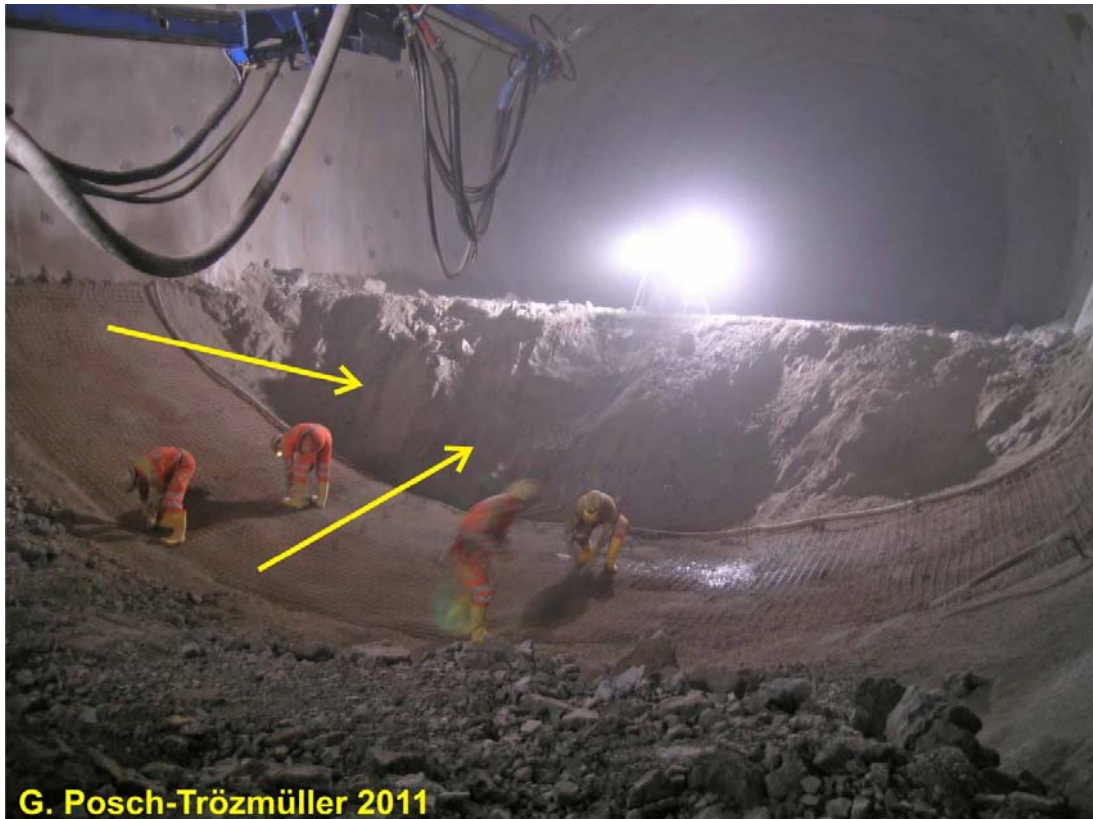
Abb. 2.1.23.: Errichtung der Sohle im Nordvortrieb, die gelben Pfeile weisen auf Aufschlüsse von Gutensteiner Kalk hin.
