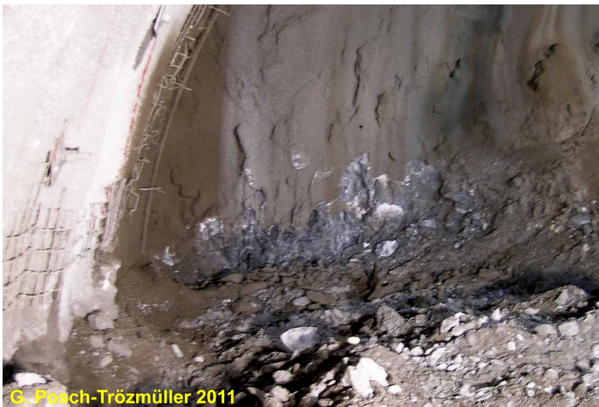
Abb. 2.1.10.: Aufschlüsse von dunklem Dolomit an der Ortsbrust.
