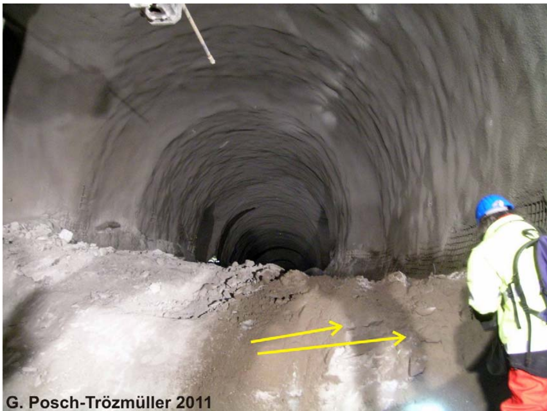
Abb. 2.1.16.: Querschlag bei etwa 970m im Haselgebirge. Die gelben Pfeile weisen auf Haselgebirgsaufschlüsse hin.
