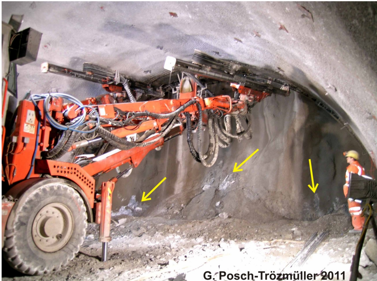
Abb. 2.1.9.: Aufschlüsse von dunklem Dolomit an der Ortsbrust (gelbe Pfeile).
