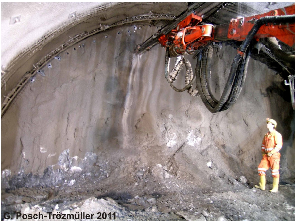
Abb. 2.1.8.: Sprengvortrieb nach NÖT an der Kalotte des Südvortriebs bei 1065,7m.
