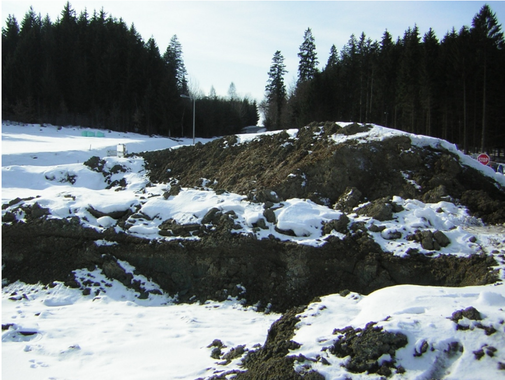
Abb. 2.3.7.: Baustelle Kleinzell im Mühlkreis: dunkelgraue bis braune sandige Schluffe und Tone (März 2010, Elfriede Ruprecht-Porod).
