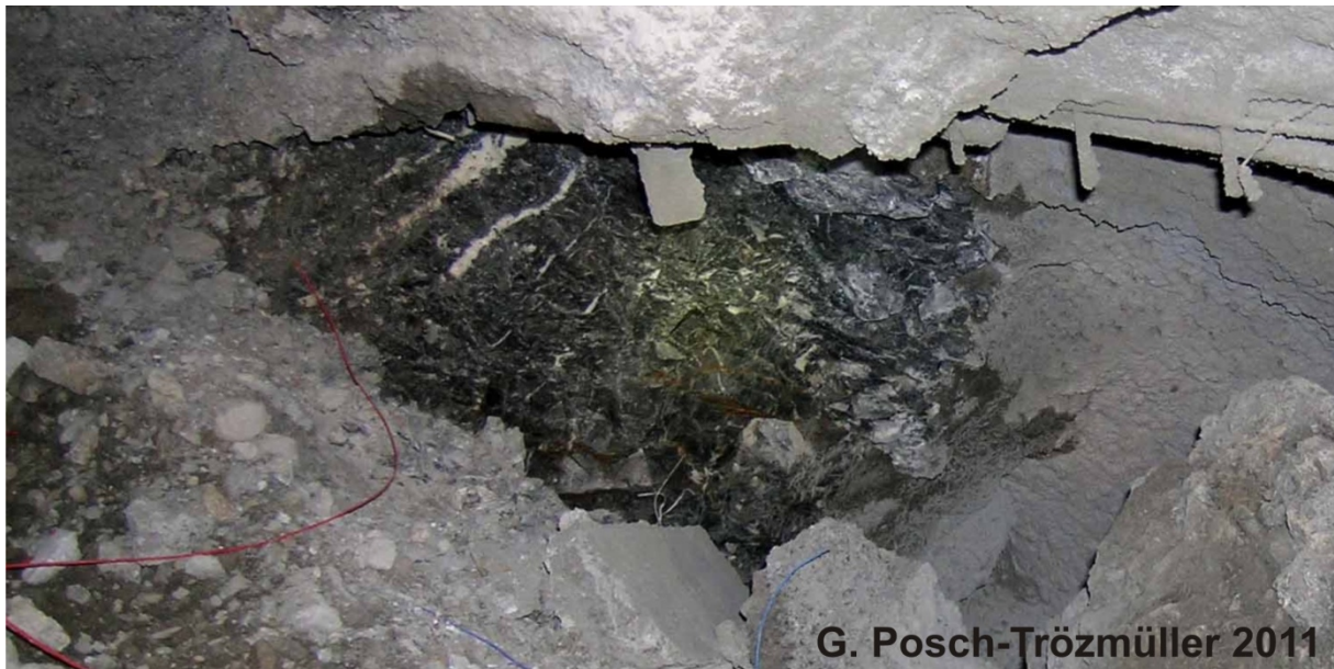
Abb. 2.1.11.: Aufschluss von dunklem Dolomit im Bereich einer Kluft am Ostulm der Weströhre, wenige Meter vor der Ortsbrust.
