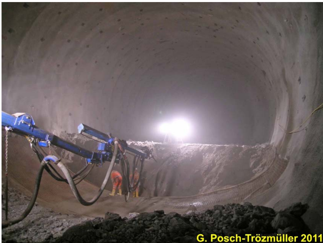
Abb. 2.1.22.: Nachziehen der Sohle im Nordvortrieb.
