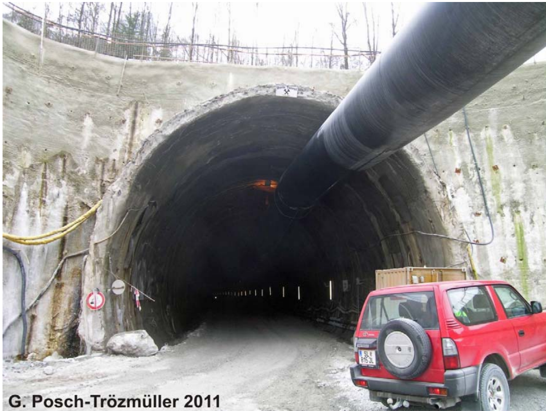
Abb. 2.1.15.: Das oberösterreichische Nordportal der Weströhre des Bosrucktunnels.
