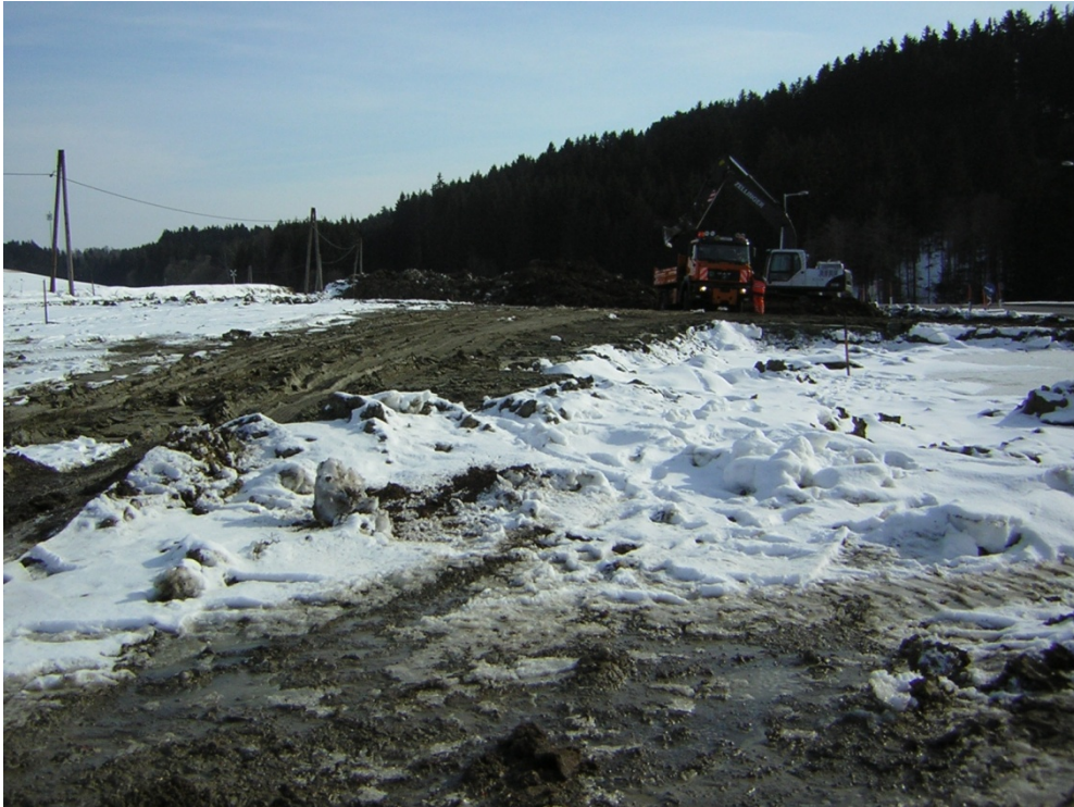
Abb. 2.3.5.: Baustelle Kleinzell im Mühlkreis: dunkelgraue bis braune sandige Schluffe und Tone (März 2010, Elfriede Ruprecht-Porod).
