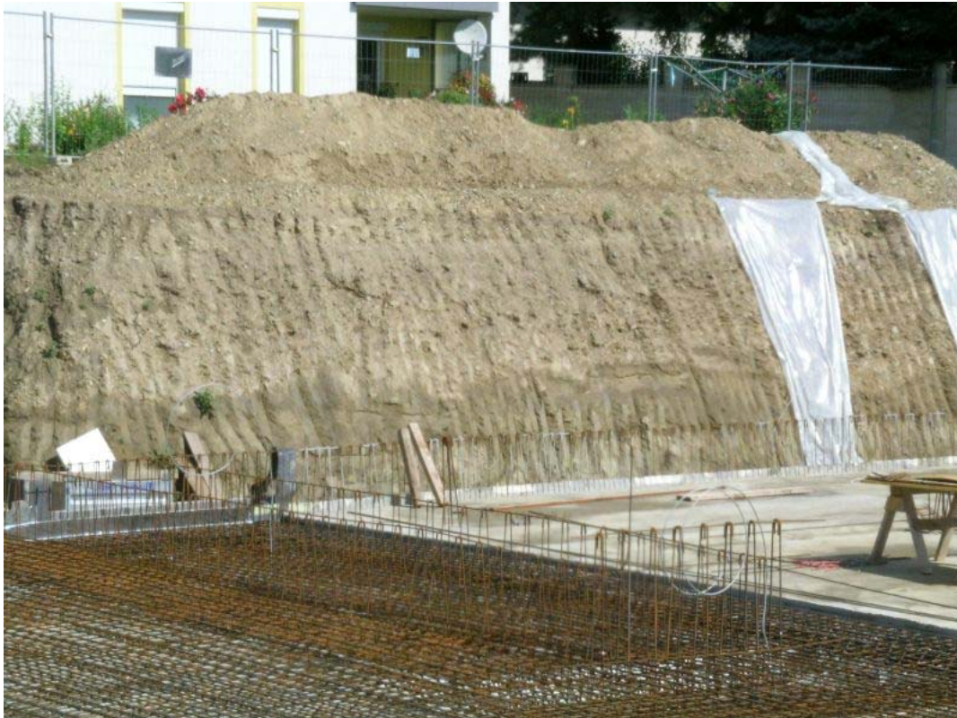
Abb. 4.13.: Baugrube in Purbach: Hangschutt bzw. Verwitterungslehm mit Kristallinbruchstücken im Hangenden. Im Liegenden treten Fein-Mittelsande auf (Foto: M. Peresson, 29.7.2010).
