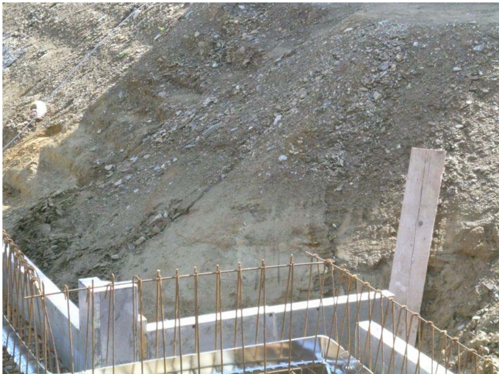
Abb. 4.12.: Baugrube in Purbach: Hangschutt bzw. Verwitterungslehm mit Kristallinbruchstücken im Hangenden. Im Liegenden treten Fein-Mittelsande auf (Foto: M. Peresson, 29.7.2010).
