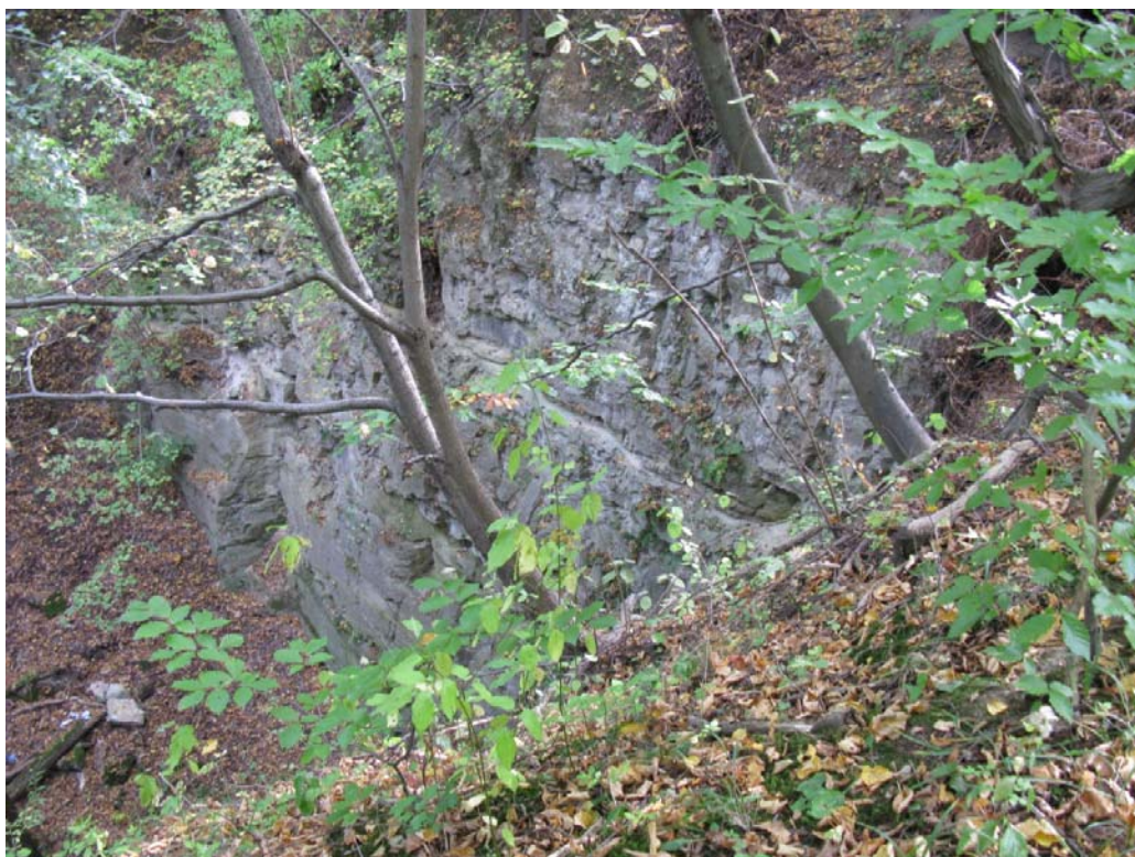
Abb. 3.23.: Hausbruch, Blick von oben (Forststraße) in den Bruch, Bruchsohle ca. 30 m tief; Foto: R. Berka.
