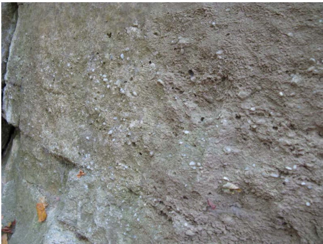
Abb. 3.46.: Kavernenbruch, Detail Gerölllage in S-Wand, Foto: R. Berka.
