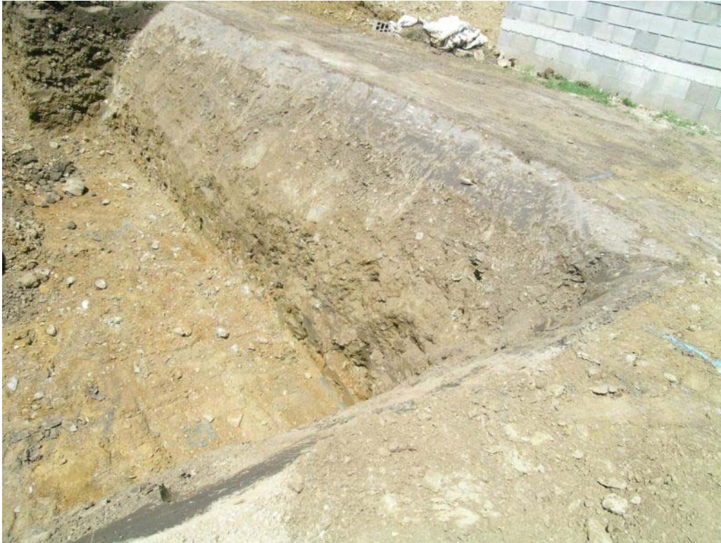
Abb. 4.14.: Baugrube Donnerskirchen: Von Hangend nach Liegend: Dunkelbrauner Bodenhorizont und Verwitterungslehm mit Kristallinbruchstücken (Foto: M. Peresson, 29.7.2010).
