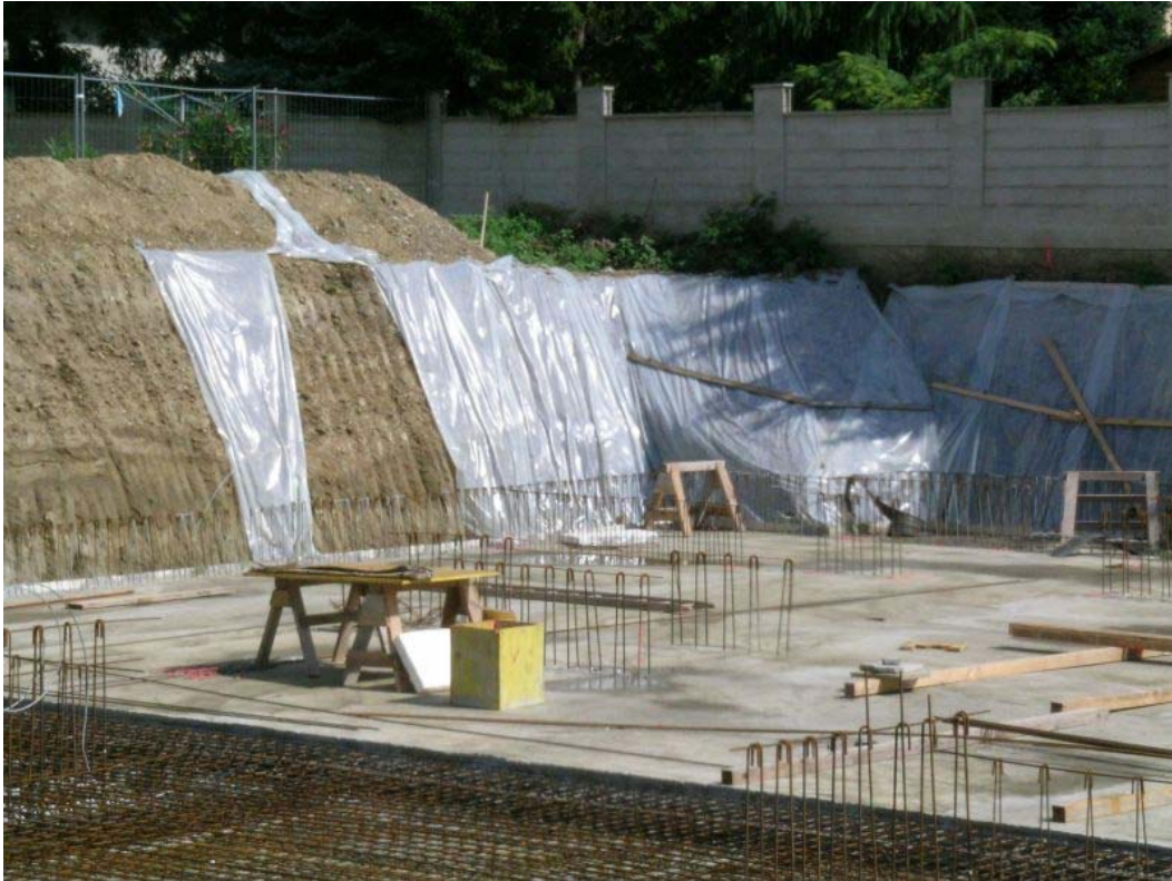
Abb. 4.11.: Baugrube in Purbach: Im Hangenden knapp 1,5m Hangschutt bzw. Verwitterungslehm mit Kristallinbruchstücken. Der liegende Abschnitt wird von pannonen? Sanden gebildet (Foto: M.Peresson, 29.7.2010).
