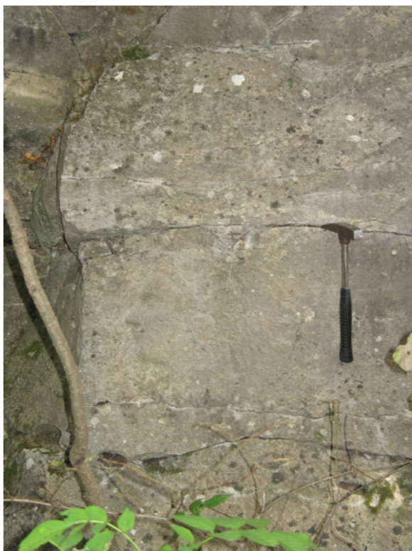
Abb. 3.72.: Steinbruch beim Reservoir, S-Wand; Foto: B. Moshhammer.
