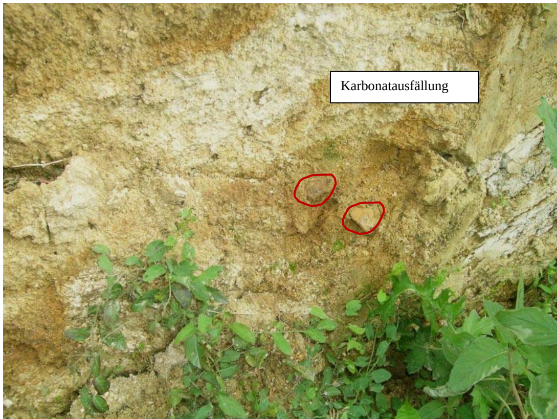
Abb. 4.8.: Aufschlussverhältnisse an der westlichen Hauswand in Breitenbrunn: Der liegende Abschnitt wird von ockergelben Schluffen und Sanden (Lehm bzw. „Verwitterungslehm“) eingenommen, in denen kristalline, stark verwitterte Komponenten (rote Kreise) eingelagert sind (Foto: M. Peresson, 29.7.2010).
