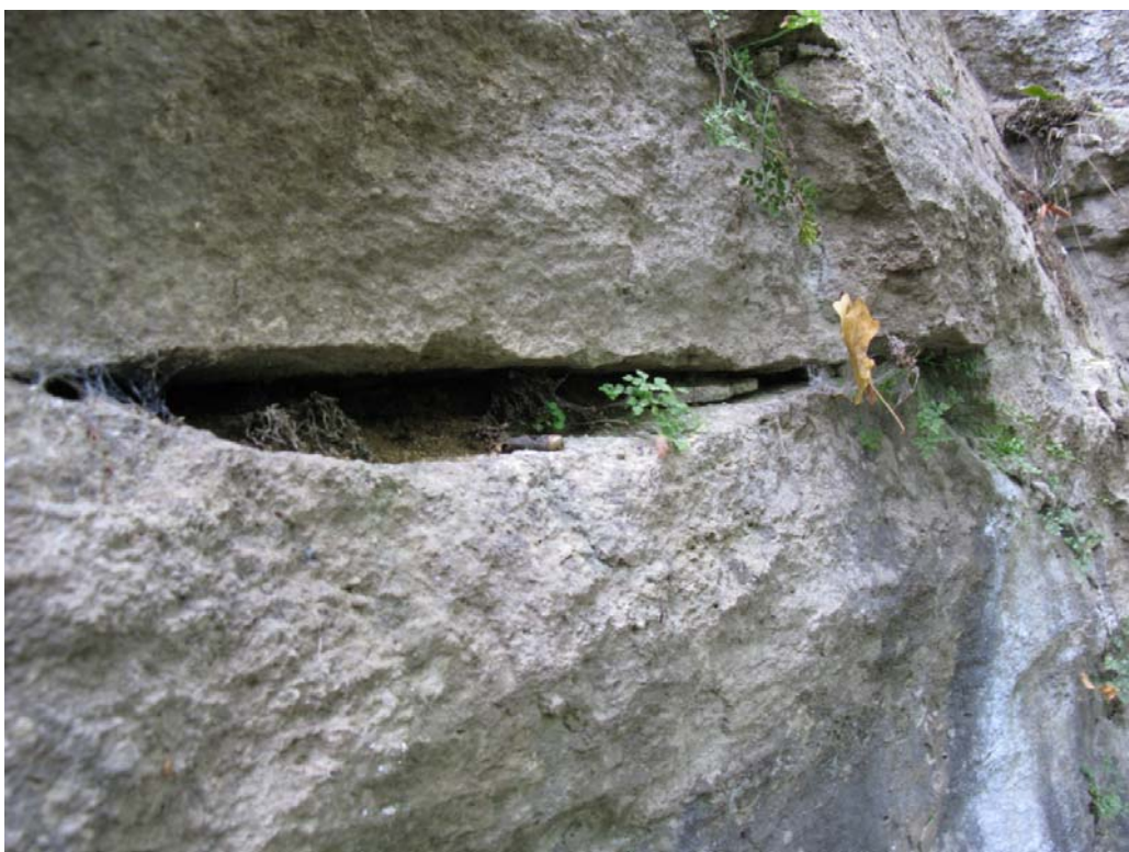
Abb. 3.47.: Kavernenbruch, Detail Schichtfugen, Foto: R. Berka.
