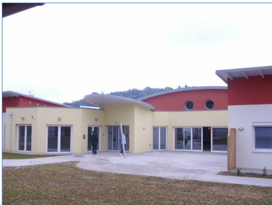
Abb. 5.1.: Das fertiggestellte Pflegekompetenzzentrum in Olbendorf ( http://olbendorf.pflege-kompetenzzentrum.at ).
