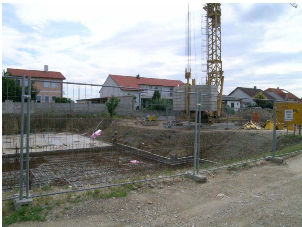
Abb. 4.10.: Errichtung einer Wohnhausanlage im Nordosten von Purbach (Foto: M. Peresson, 29.7.2010).
