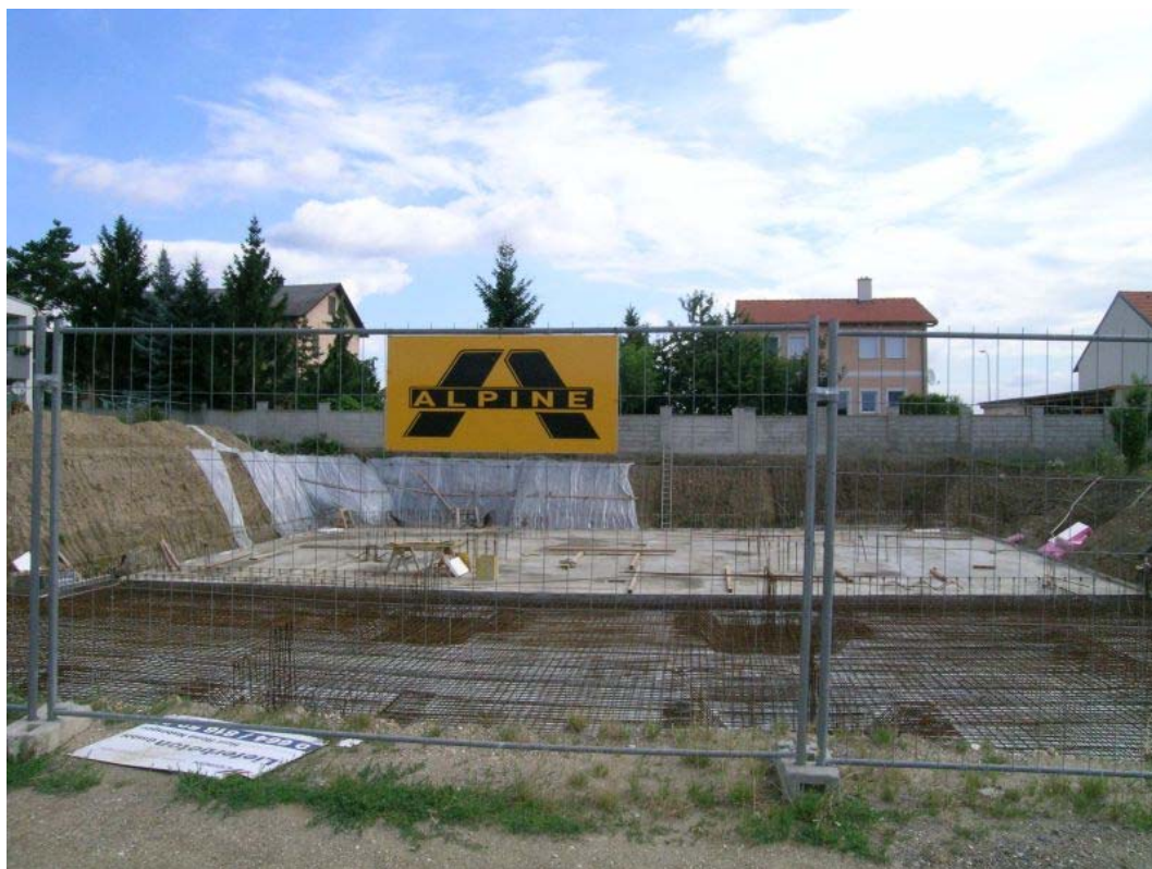
Abb. 4.9.: Errichtung einer Wohnhausanlage im Nordosten von Purbach (Foto: M. Peresson, 29.7.2010).
