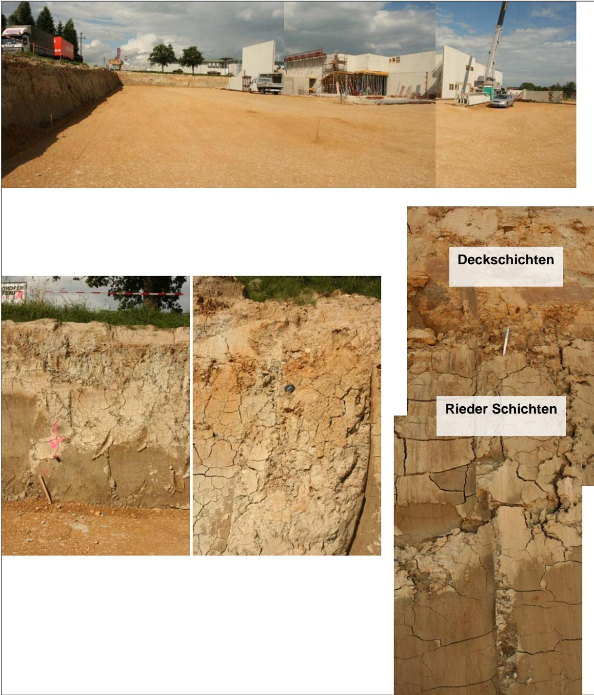
Abb. 3.1.3.: Dokumentation der Baugrube mit Rieder Schichten bei Rabenberg (ÖK 47)
