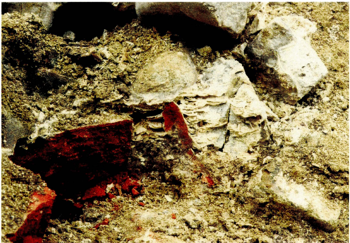
Abb. 11: Karbonatausfällungen an Sandsteinblöcken (29. Jänner 2001)
