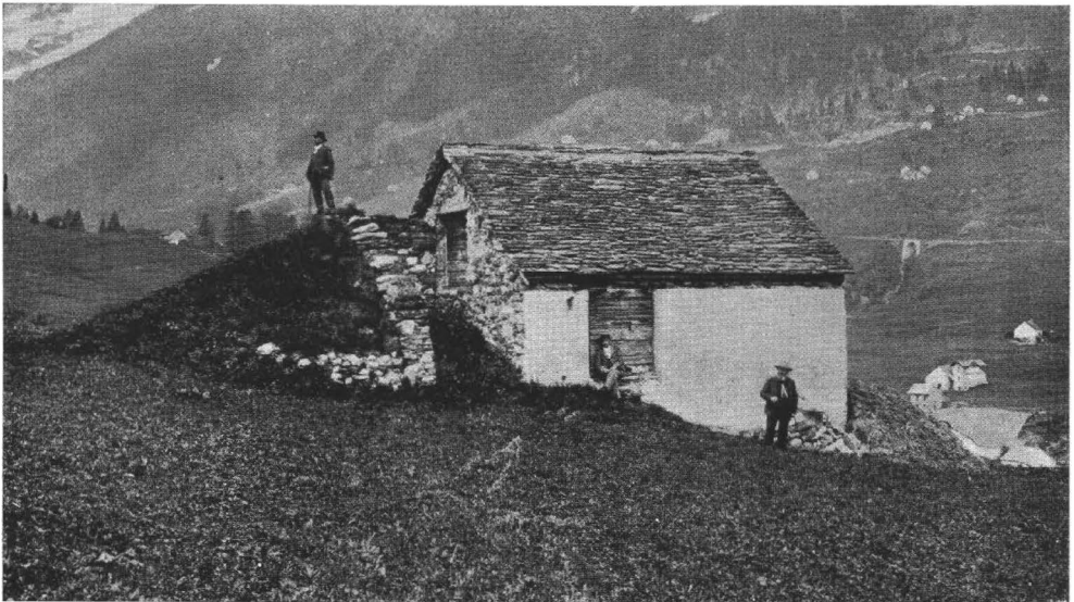
Abb. 76. Primitive Spaltecke zum Schutze einer Almhütte
