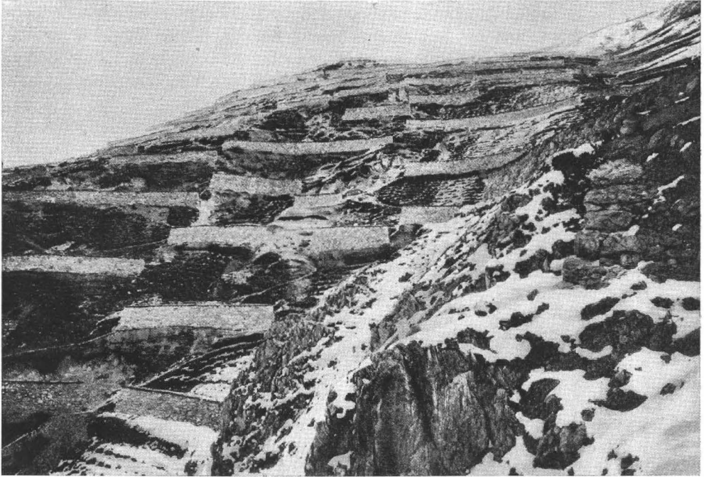
Abb. 71. Schneefänge auf Muot bei Bergün (Albulabahn)
