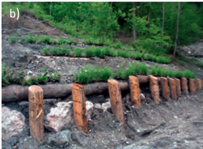
Abb. 8. Offenhalten des Hauptgerinnes mit Pilotierungen (a), Krainerwände mit Weiden (b).
