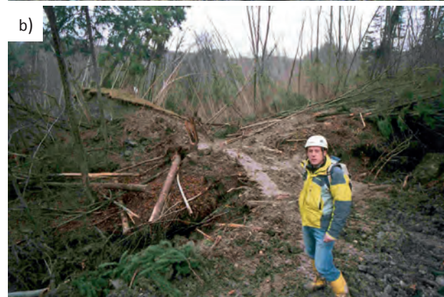
Abb. 7. Initiales Rutschungsereignis im Frühjahr 2006 (a). Abgleiten und Auffahren der Massen entlang von Scherflächen im November 2007 (b).
