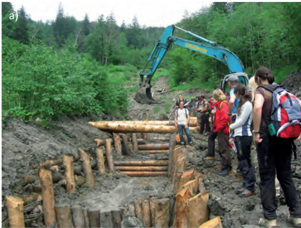
Abb. 8. Offenhalten des Hauptgerinnes mit Pilotierungen (a), Krainerwände mit Weiden (b).
