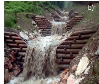
Abb. 9. a) Abspundung des Lidringgrabens gegen den Zentralbereich der Rutschung samt Ableitung der Oberflächenwässer des gleichnamigen Baches. b) Errichtung und Funktion des neuen Liedringbachbettes (Foto: Wolfgang Gasperl).
