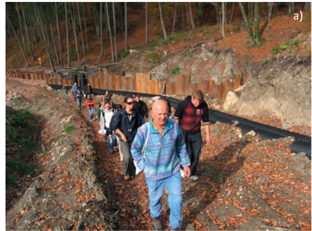
Abb. 9. a) Abspundung des Lidringgrabens gegen den Zentralbereich der Rutschung samt Ableitung der Oberflächenwässer des gleichnamigen Baches. b) Errichtung und Funktion des neuen Liedringbachbettes (Foto: Wolfgang Gasperl).
