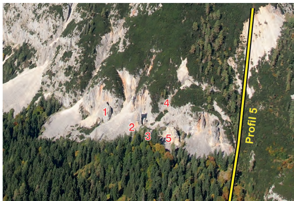
Abb. 5. Relative Bewegungsmessung mittels Präzisionsmaßband (Punkte 1–5) und geoelektrische Tiefenerkundung (gelbe Linie) (Foto: Sandra Melzner, GBA – GEORIOS Datenbank).
