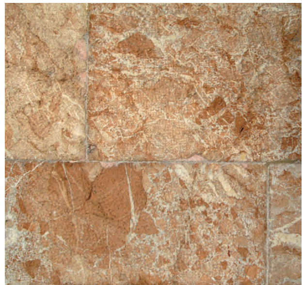
Abb. 6. Das dominierende Baumaterial der Fassade des Marmorschlossls ist der Traunsee-Marmor, eine pastös rosarote und wohl durch „den Zahn der Zeit“ etwas verblasste Kalksteinbrekzie der frühen Jura-Zeit.
