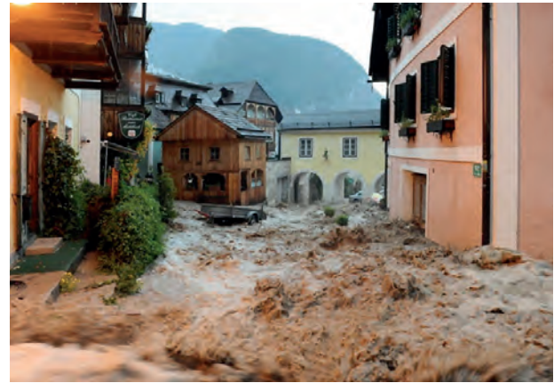
Abb. 6. Situation beim Ereignis vom 18. Juni 2013 im Bereich des Oberen Marktplatzes/Badergraben (Foto: Frühauf, 2013).
