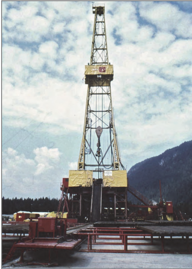
Abb. 1: Die Tiefbohrung Vorderriß I im Sommer 1978.
